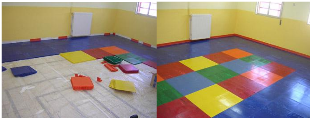
Fig. 56: Instalación del suelo
