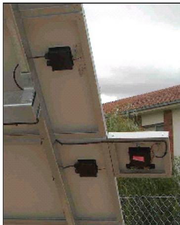
Fotografía 4.1.4\_1 Célula calibrada solidaria con estructura del campo generador
