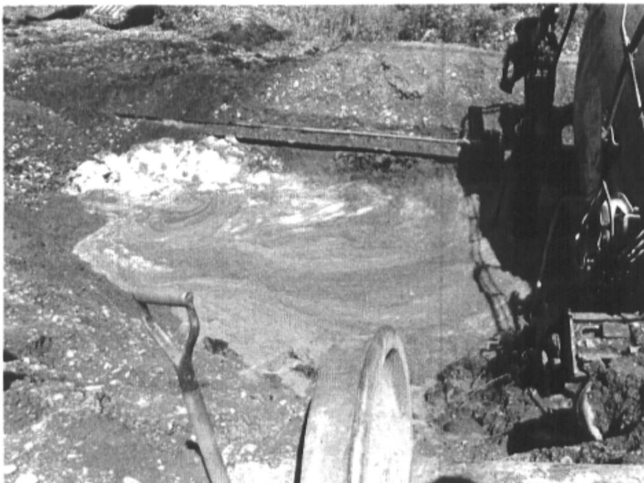
Figure 4.13 : Photographie du trou au centre de la voie ferrée où les rails ont été sectionnés ce qui a entraîné le déraillement de l'Ultratrain en 2004.
