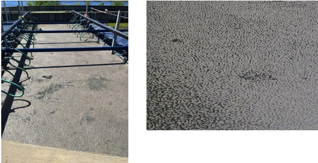
Figure 43 Remise en suspension de la matière dans les zones de décantation
