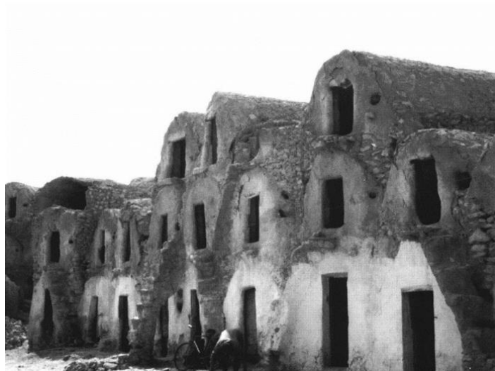
Figure 25 Les Ghorfa de Médenine (greniers collectifs abandonnés). Photo G. Camps (vers 1970)
