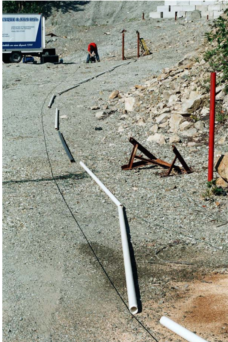
Photo 3. Préparation des équipements pour la descente de la caméra submersible dans l'ancien puits de ventilation 1100
