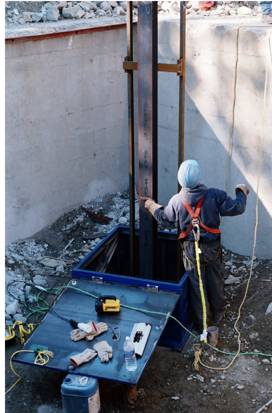
Photo 7 et 8. Descente de la poutre d'acier dans le puits 1100.
