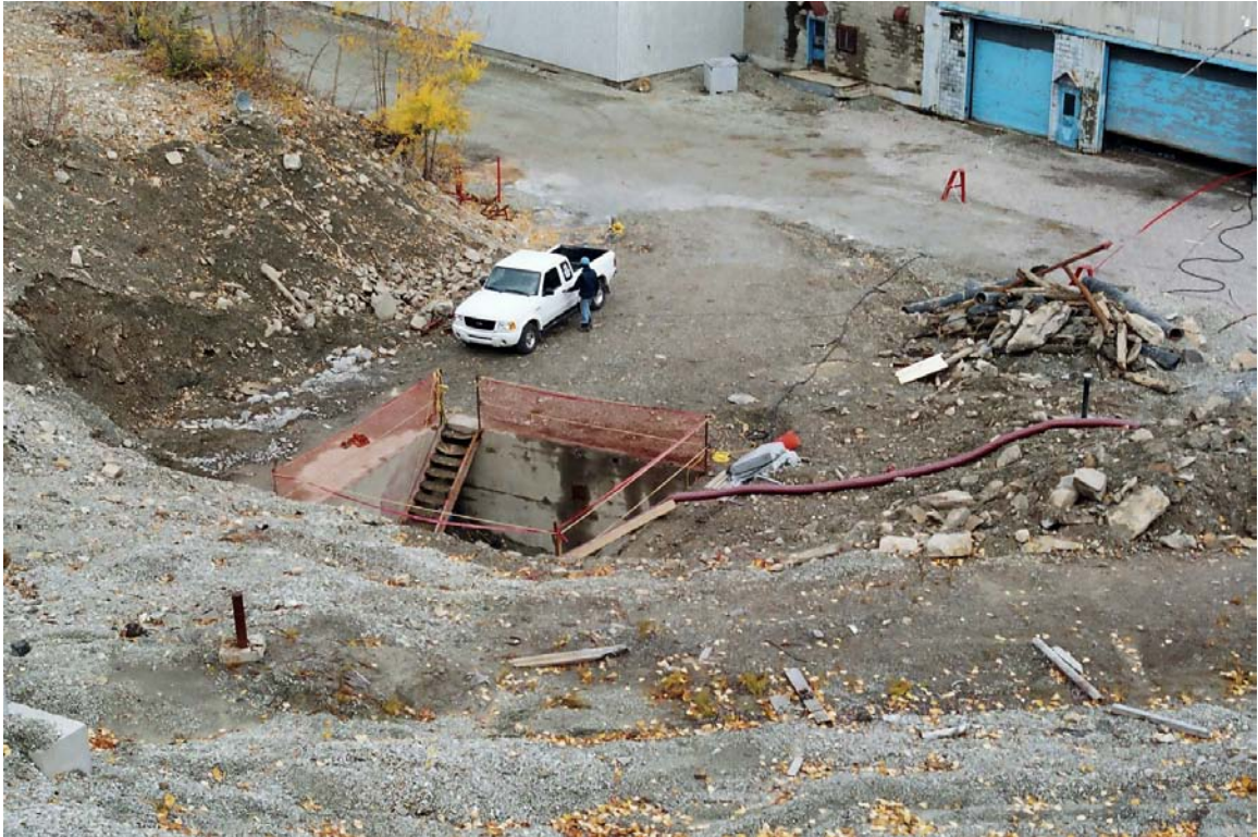
Photo 13. Vue d'ensemble du site durant l'essai de pompage.
