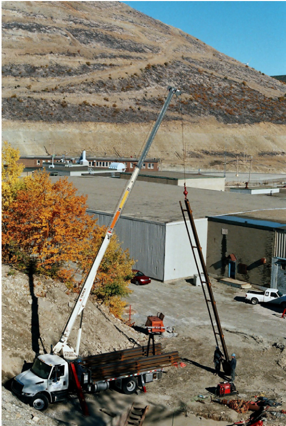
Photo 7 et 8. Descente de la poutre d'acier dans le puits 1100.
