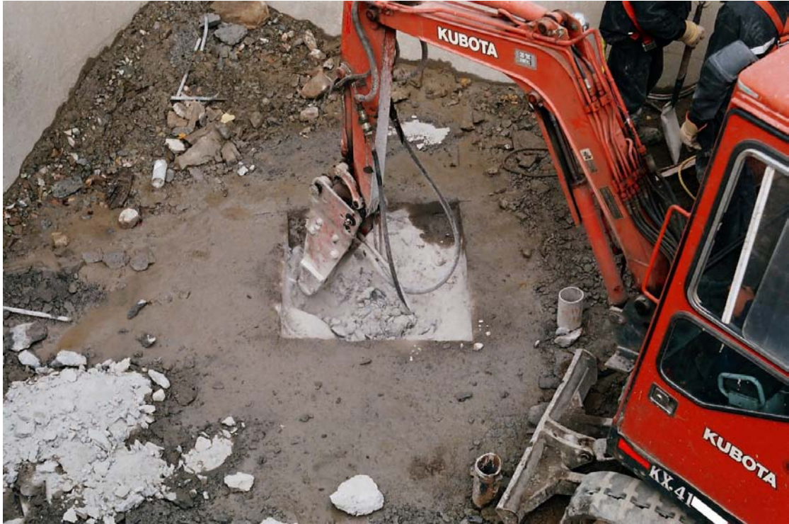
Photo 6. Ouverture du capuchon de béton au puits 1100.
