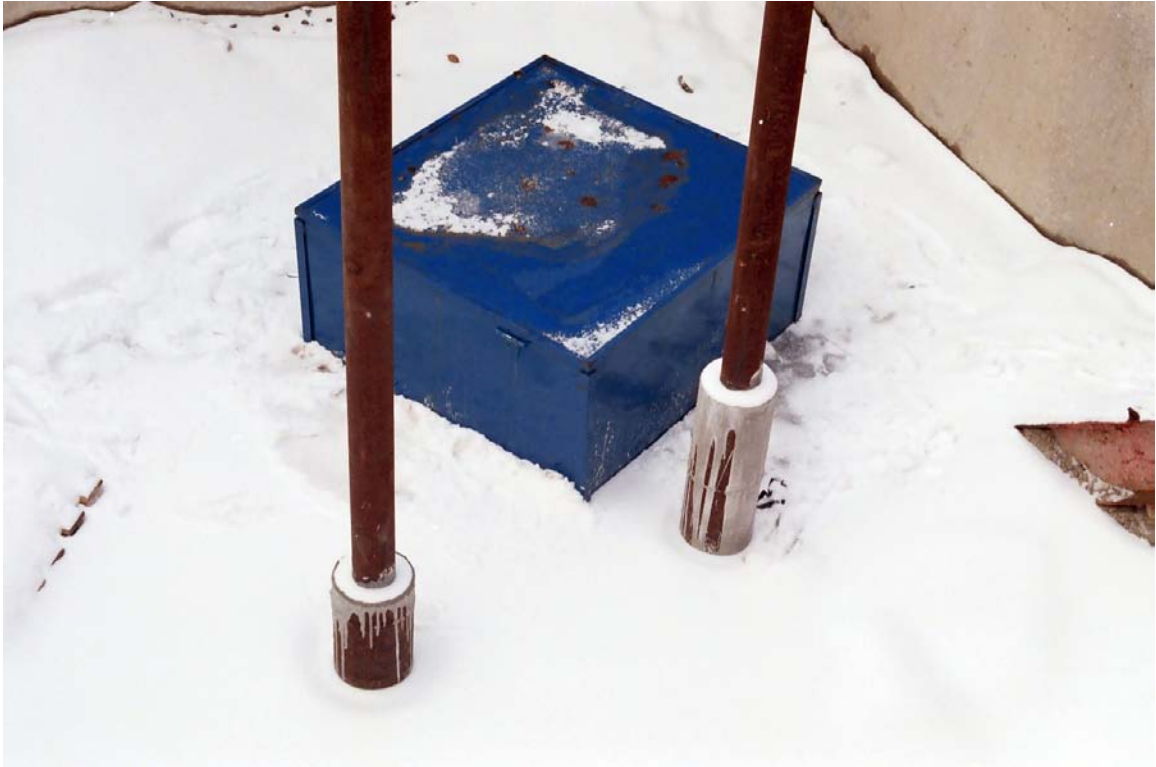
Photo 15. Boîte d'acier au-dessus de l'ouverture du puits 1100 après l'essai de pompage.
