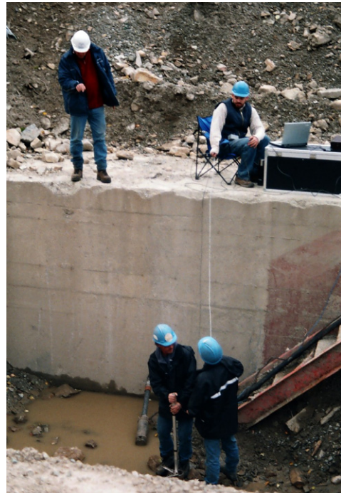
Photo 3. Visionnement de l'intérieur du puits 1100 à l'aide d'une caméra submersible.
