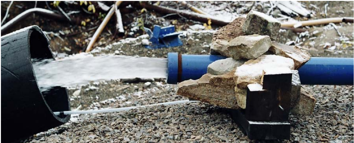
Photo 11. Décharge de l'eau souterraine pompée au puits 1100.
