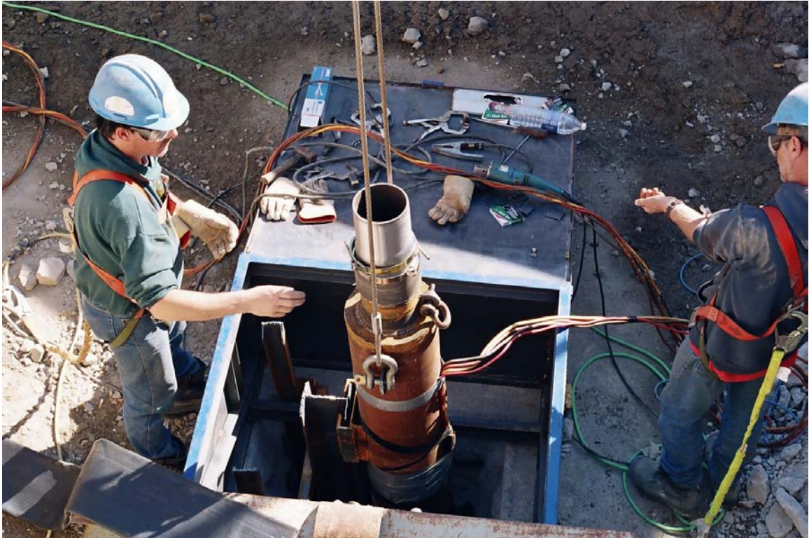
Photo 9. Descente de la pompe submersible dans le puits 1100.
