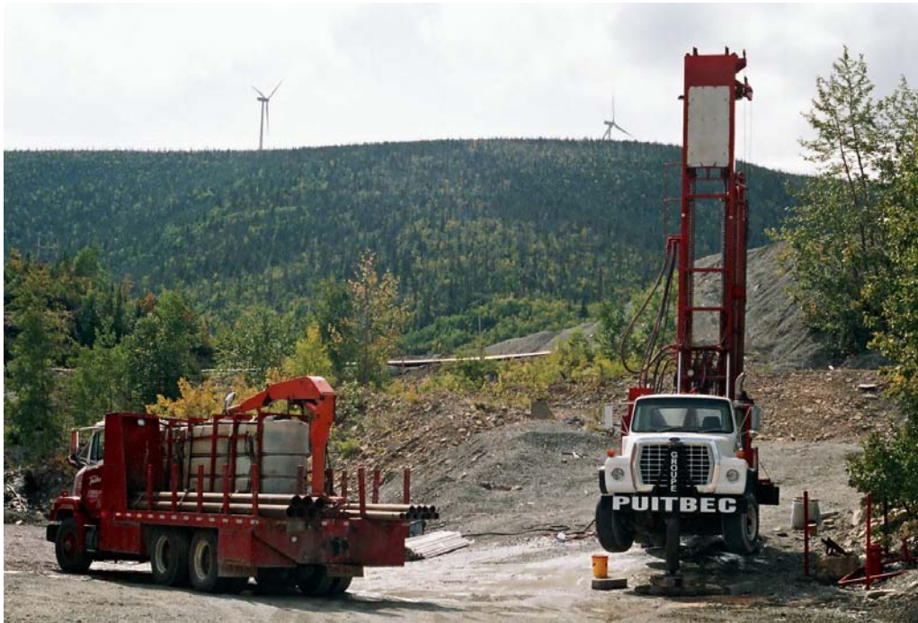
Photo 1. Forage du puits d'observation PO-115.
