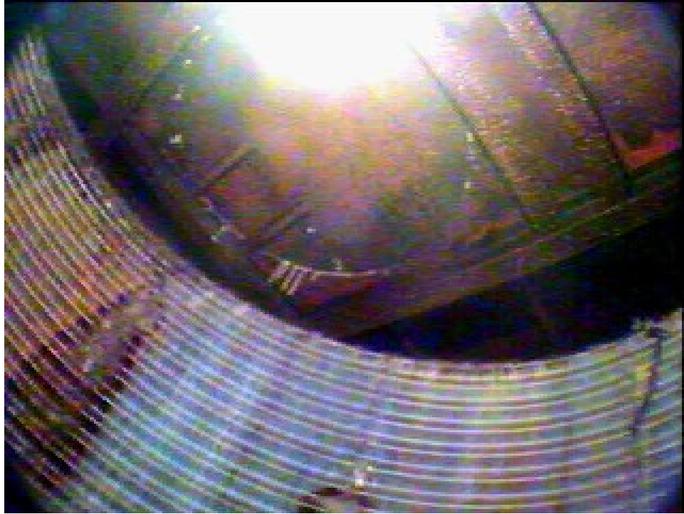
Photo 4. Dessous de la plaque d'acier sous le capuchon de béton du puits 1100.
