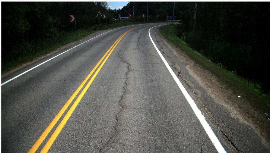
Figure 29 : Dégradations sur la section de Lac-Delage. Été 2014
