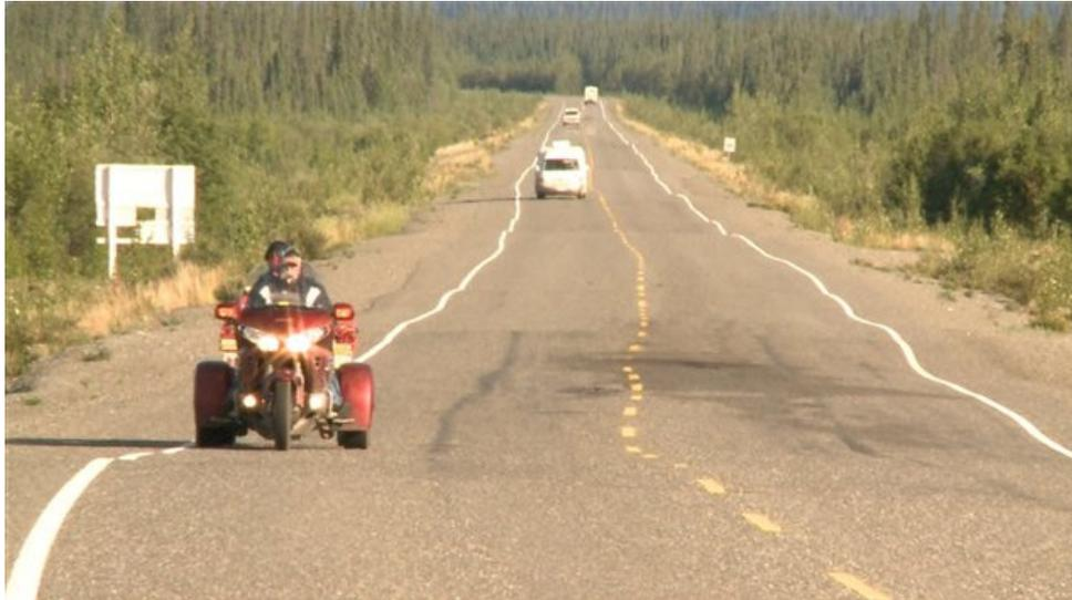
Figure 15 : Ondulations de la route de l'Alaska dues à des tassements différentiels (Samson, 2015)
