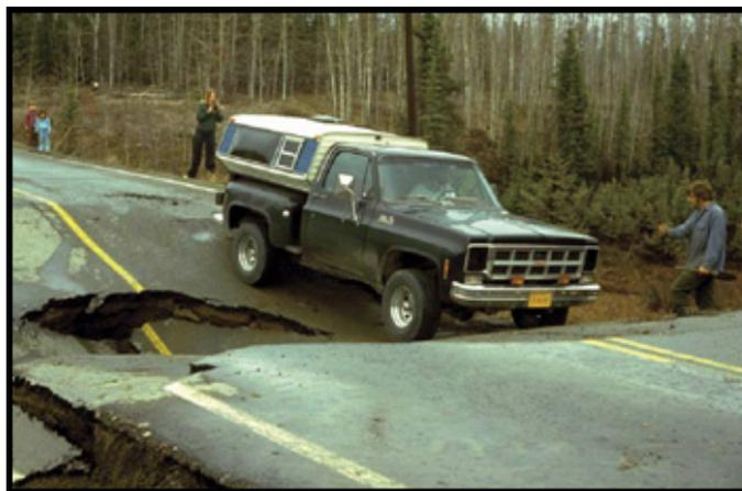
Figure 16 : Affaissement d'un remblai routier dû à l'apparition d'un thermokast (Université de l'Idaho)
