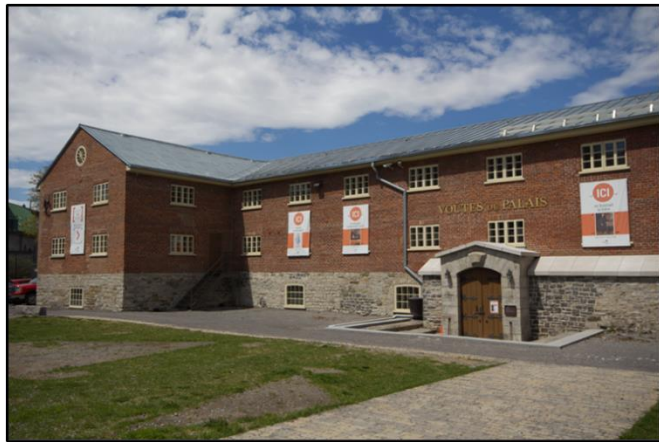
Figure 8. Le bâtiment actuel sur le site du palais de l'Intendant (Paradis, 2019)
