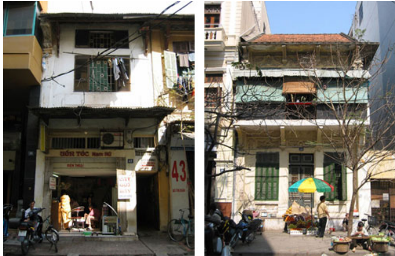
Figure 4.46. Fermeture d'un balcon pour agrandir la pièce.
