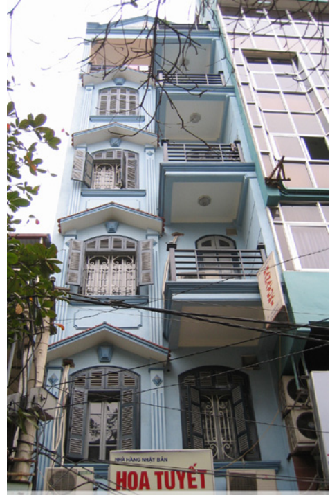
Figure 4.27. La forme régulière de maison contemporaine à Hanoi.
