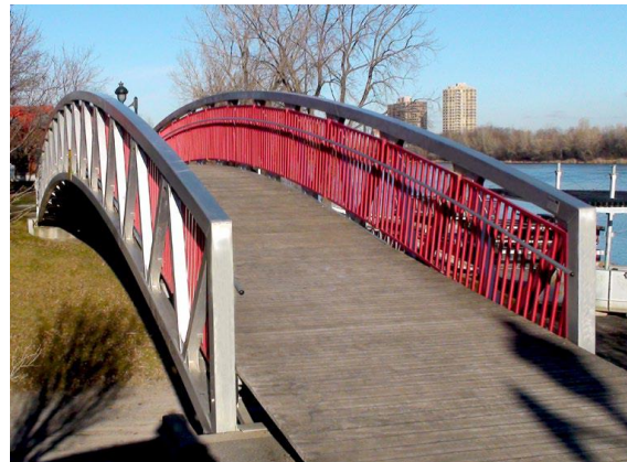
(b) Passerelle piétonnière
