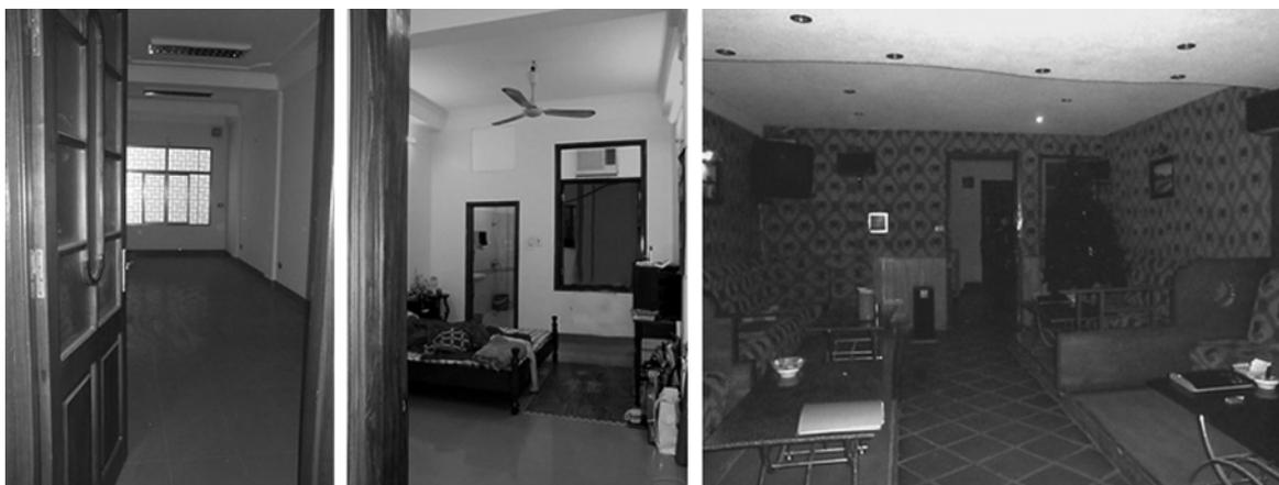
Figure 4.1.26: Mesures d'éclairage et de ventilation naturels dans les parties arrière des CHPO : ouverture sur l'extérieur (TT-057), ouverture sur puits technique (TVV-029), aucune ouverture (BTX-039)
