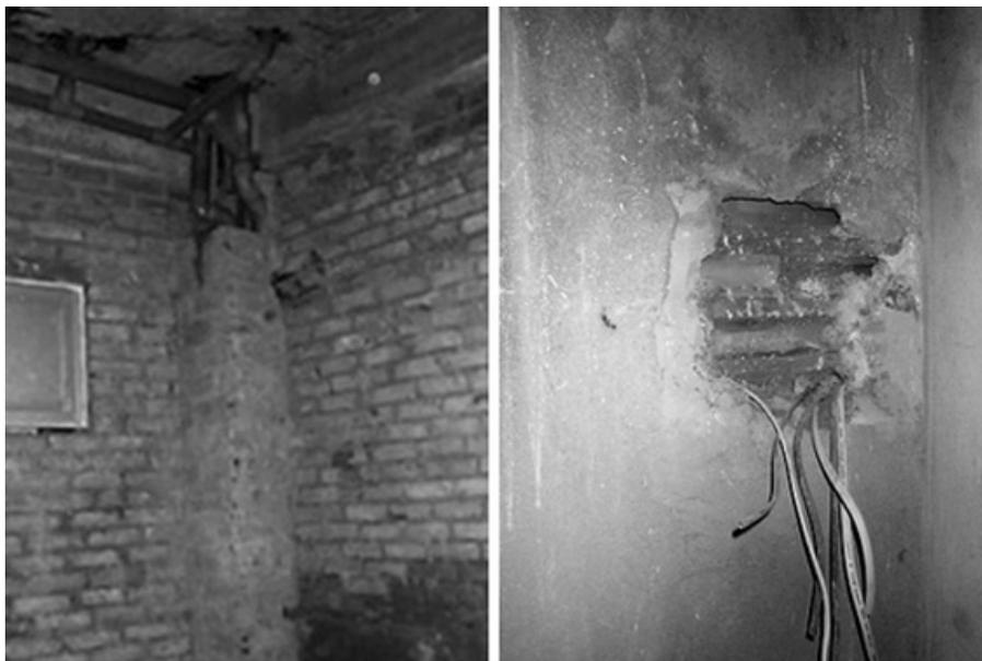
Figure 4.1.3 : Soufflage de brique pour tuyaux de plomberie et intégration des fils électriques dans le fini de crépi
