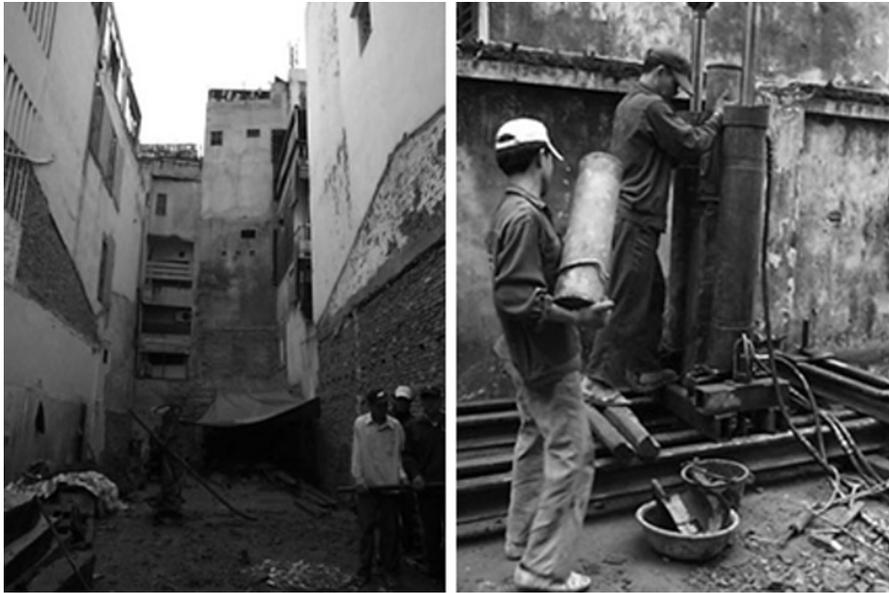
Figure 4.1.1 : Préparation d'un terrain (2005) et enfoncement hydraulique des pieux (2005)
