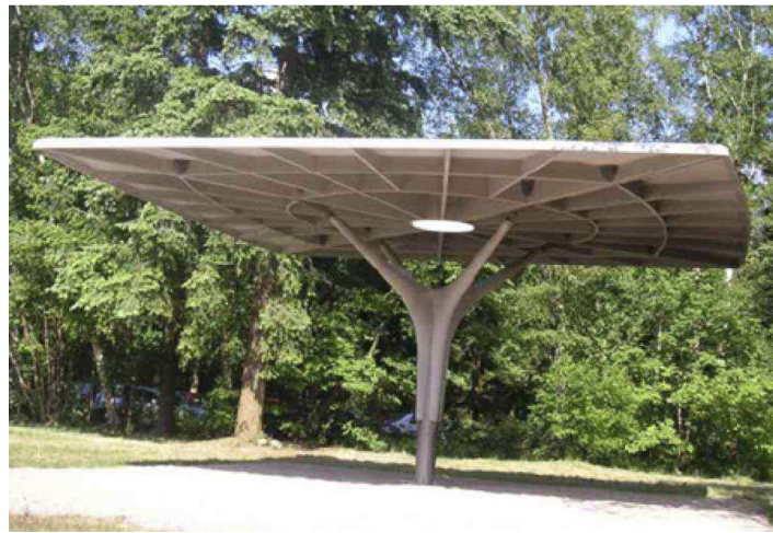
FIGURE 2.2 – Abris en BFUP, aire de repos, Pays-Bas
