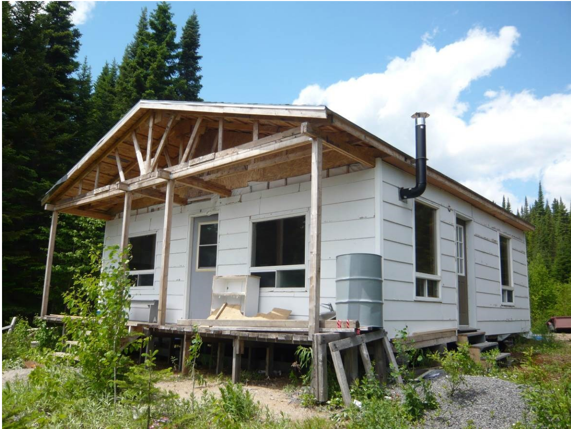
Les différentes étapes de reconstruction du camp Figure 4 : les fondations ; figure 5 : l'ancien campement où dormait le grand-père avant l'existence du camp ; figure 6 : le camp reconstruit en planches.
