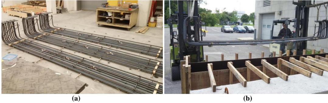
Figure 3-4. (a) Cage d'armature longitudinale préassemblée en laboratoire ; (b) Insertion des cages d'armature dans les coffrages par des chariots élévateurs
