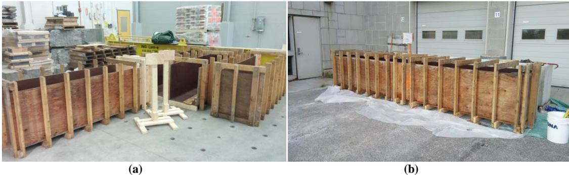
Figure 3-3. (a) Demi-longueurs de coffrages préassemblées en laboratoire ; (b) Coffrage assemblé à l'extérieur
