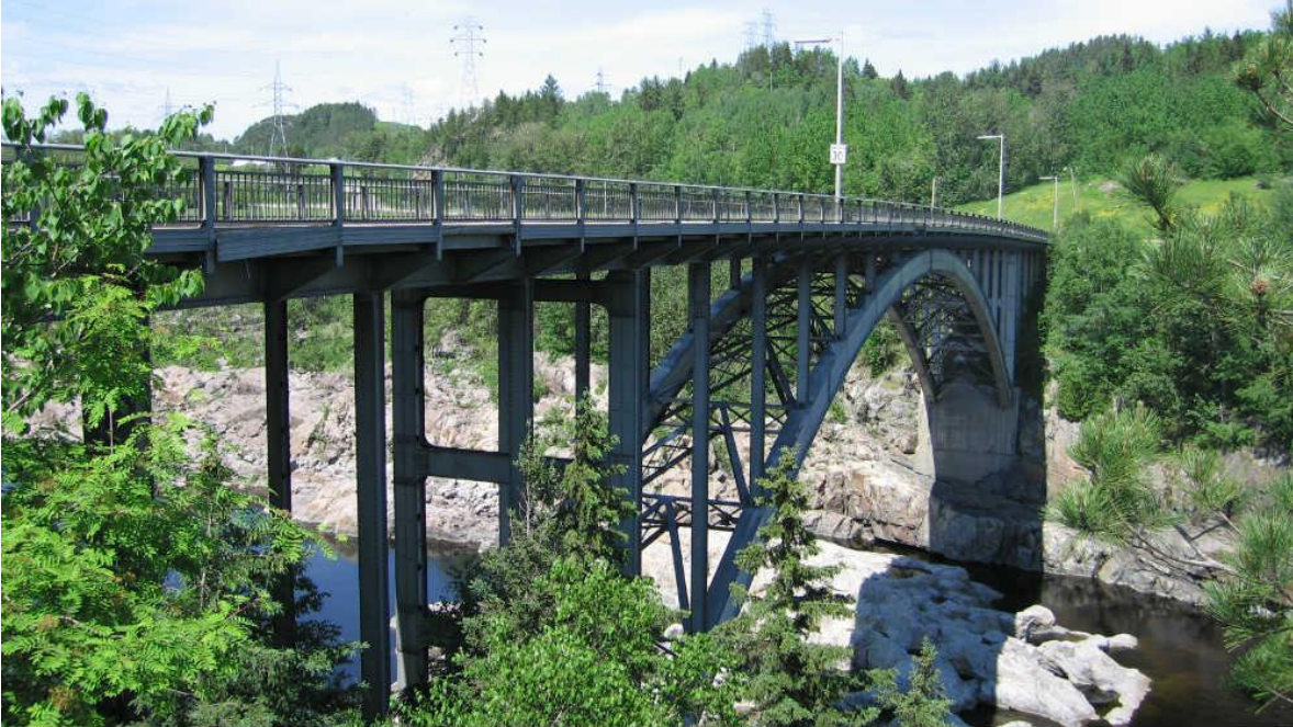
Figure A.1: Photographie du pont d'Arvida entièrement fait en aluminium, construit en 1950, réalisée par Potvin (2006)
