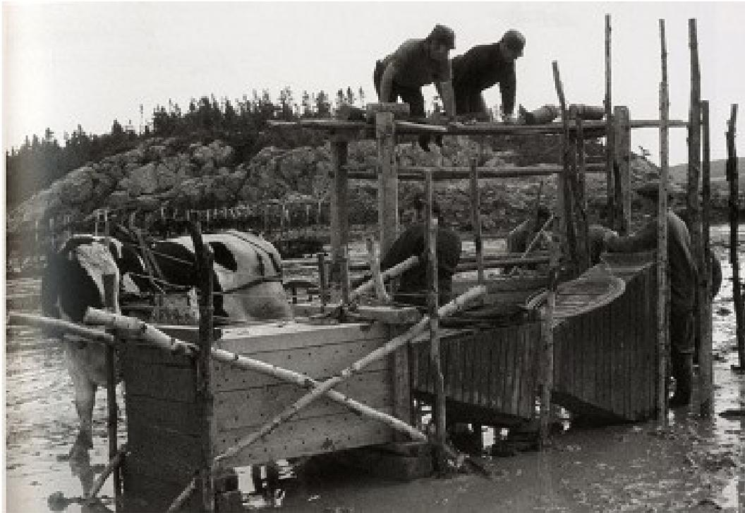
**Figure 8.4 : Installation d'une pêche à fascine. Notez ici la quantité d'hommes pour mettre en place le piège et la vache pour tirer l'équipement. Il est aussi possible de voir un autre piège derrière l'animal qui n'utilise plus les claies de fascine. La situation de la pêche à l'anguille est entre tradition et modernité. Source : Fonds Musée du Bas-Saint-Laurent, date inconnue.**
