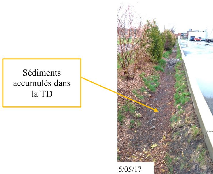
**Figure 51 - Sédiments à la surface de la TD**
