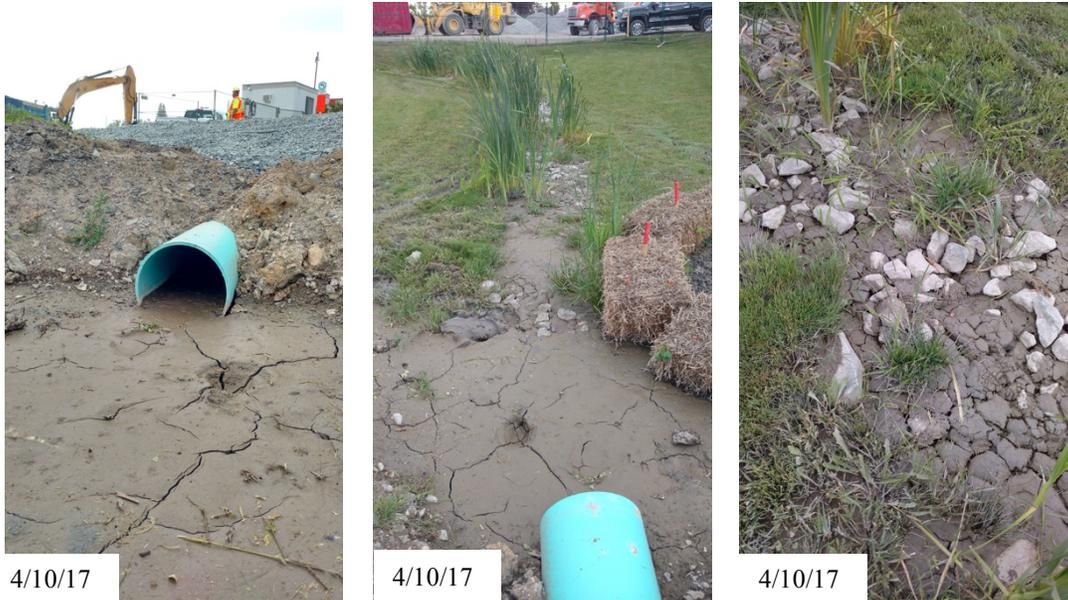
**Figure 54 - Accumulation de sédiments à l'entrée du bassin sec**
