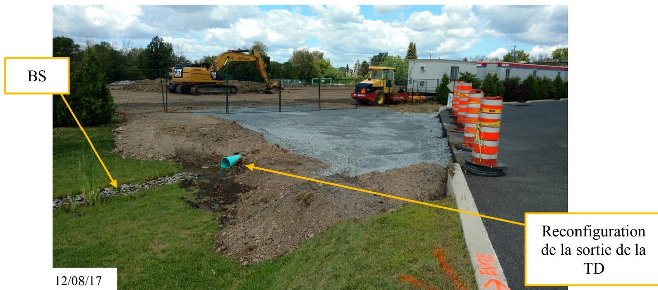
**Figure 53 - Réaménagement de la sortie de la TD et du BS**
