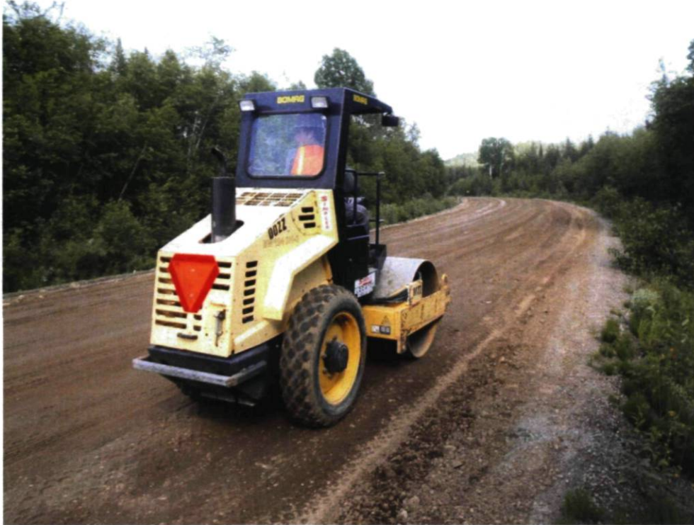
Figure 4.8 : Rouleau compacteur servant à la compaction de la planche référence et de celle stabilisée.
