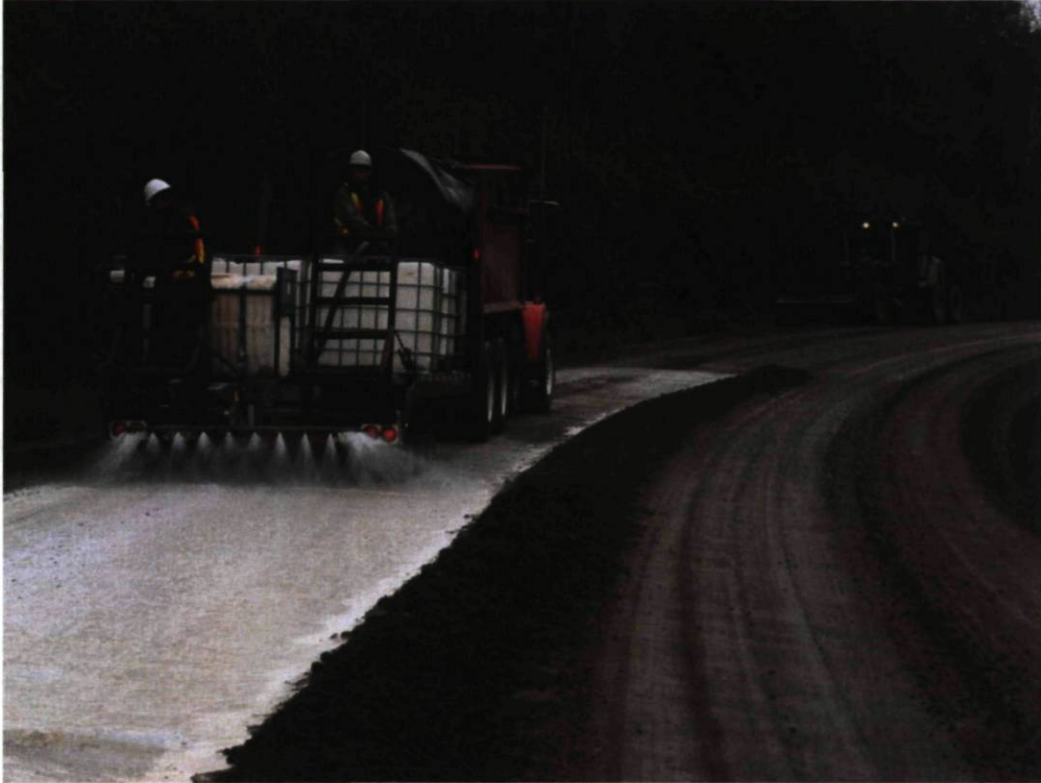
Figure 4.6 : Épandage de la couche inférieure (profondeur de 5 cm) de l'agent stabilisant sur la partie gauche de la route.
