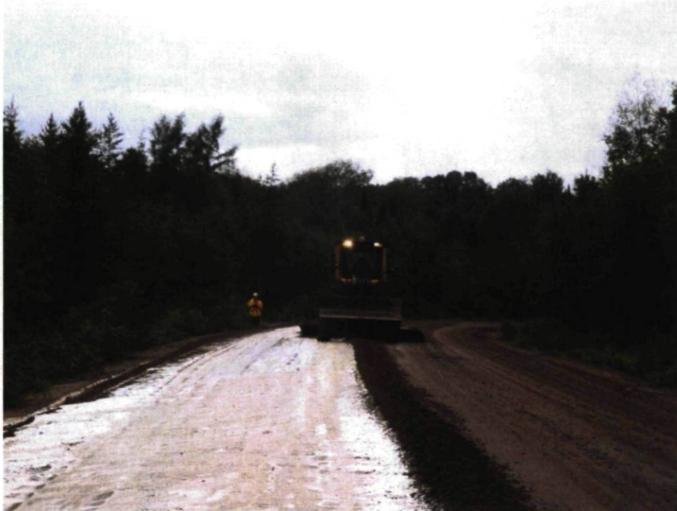
Figure 4.7 : Niveleuse remplaçant le matériel initialement enlevé afin de permettre l'épandage de la couche inférieure de l'émulsion polymère.
