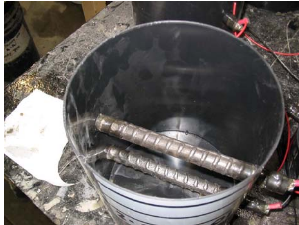
Figure 4-8 : Installation des barres dans les moules
