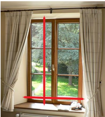
Figure 41: Méthode de prise de mesure des dimensions de fenêtres
