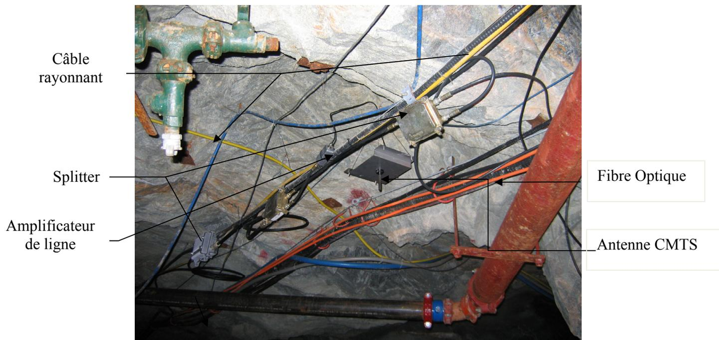
Figure 2.6 Différentes infrastructures filaires (ou technologies) existant en milieu souterrain (Mine CANMET)
