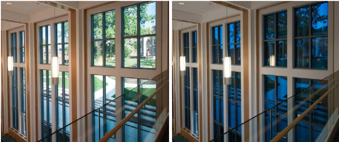
Figure 1.2 : Fenêtres électrochromes à l'état clair (à gauche) et dans un état coloré (à droite). Crédit: Sage Electrochromics
