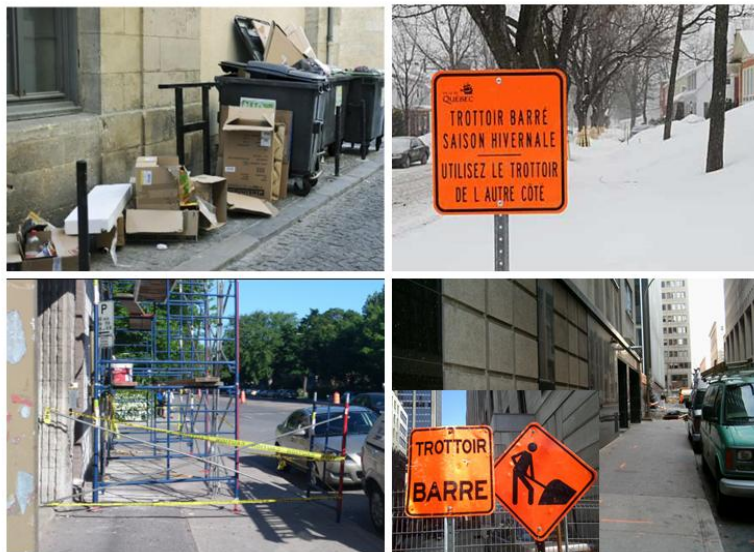
Figure 1.3: Exemple d'obstruction sur les trottoirs
