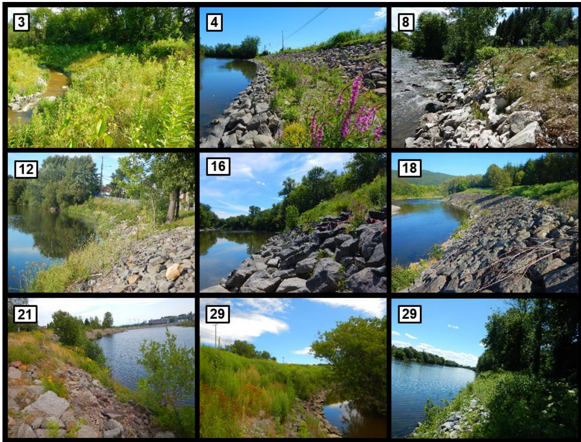
Figure 5.5. Variabilité de la physionomie des ouvrages d'enrochement de berge selon leur âge en années (précisé dans l'encadré pour chaque sous-figure). Le degré de végétalisation (intentionnelle ou spontanée) dans l'ouvrage semble indépendant de l'âge de l'enrochement, jusqu'à 21 ans après l'implantation. Photographies : Maxime Tisserant.
