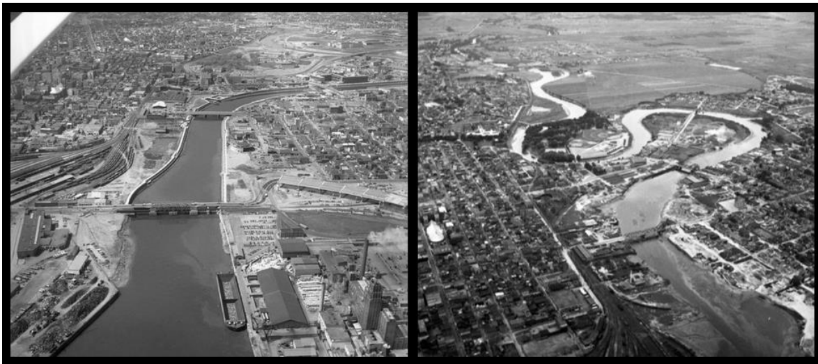
Figure 1.9. Exemples de vastes travaux de rectification de cours d'eau dans la Ville de Québec. À gauche, les grandes opérations de chenalisation de la rivière Saint Charles, avec des digues de béton recouvrant les berges sur une distance de 4 km, maintenant "débétonnées". À droite, l'ancien méandre de la rivière Saint-Charles devenu l'actuel parc Victoria. Photographies : Société Historique de Québec
