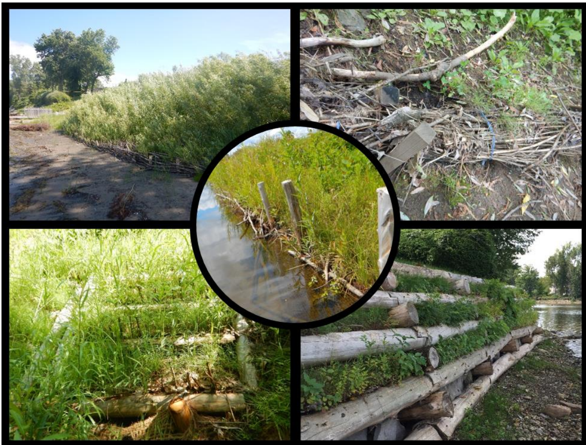
Figure 1.12. Variété des techniques de génie végétal. De gauche à droite et de haut en bas : tressage et matelas de branches, fascines, lits de plants et plançons, caisson végétalisé. Au centre : pieux vivants et tressage. Photographies : Maxime Tisserant.
