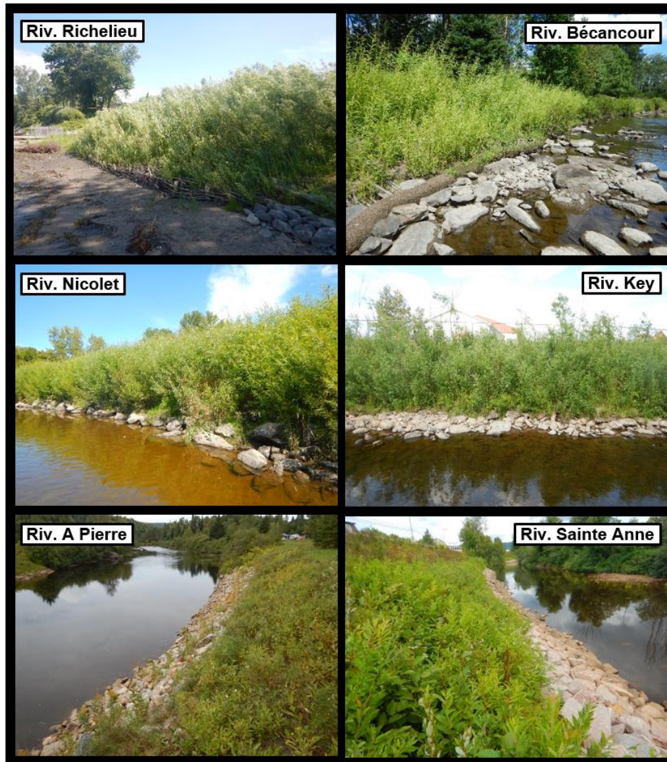
Figure 1.17. Physionomie de la végétation sur les berges stabilisées avec des techniques de génie végétal. Photographies du haut : ouvrages de génie végétal pur (utilisation de techniques issues du génie végétal sur toute la surface de la berge). Photographies du milieu : ouvrages de génie végétal avec un enrochement de pied de berge (génie végétal recouvrant la majeure partie de la berge, et protection du pied de berge avec un enrochement). Photographies du bas : ouvrages de génie mixte (enrochement recouvrant une plus grande proportion de la berge que la catégorie précédente, mais restreint à la zone située sous la ligne des hautes eaux). Les effectifs pour chaque type sont précisés dans le Tableau 1.2 et les aménagements schématiques de ces techniques, ainsi que l'enrochement, sont illustrés dans la Figure 2.2. Les cours d'eau sont précisés pour chaque site dans l'encadré. Photographies : Maxime Tisserant.
