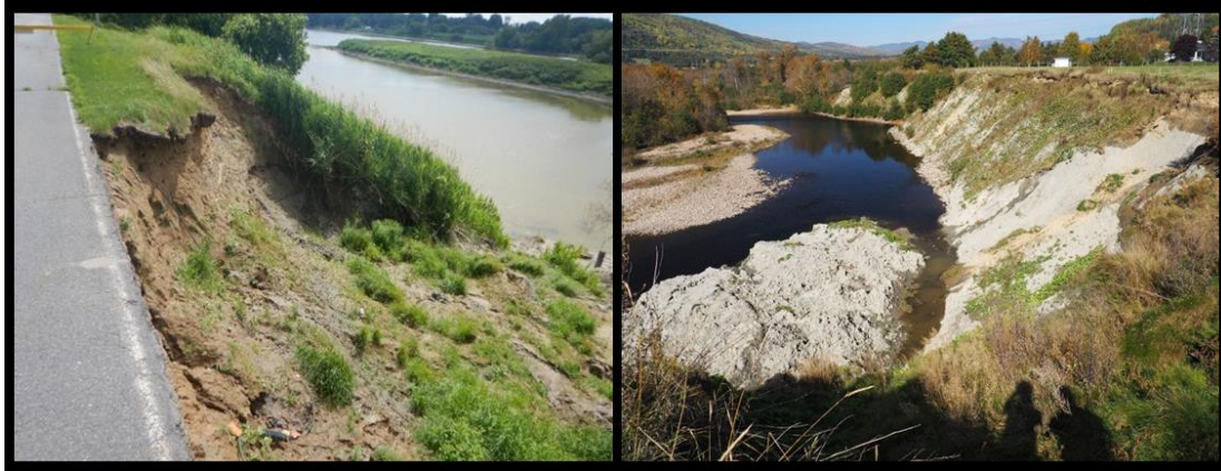
Figure 1.2. Exemples de glissement de terrain en argiles sensibles à proximité d'un cours d'eau, induits par la présence d'une route (gauche, rivière Saint-François) ou par l'érosion du cours seulement (droite, rivière Du Gouffre). Photographies : Maxime Tisserant.
