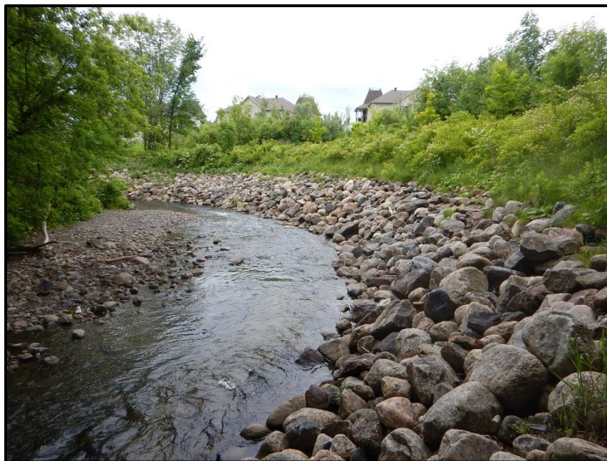
Figure 1.3. Travaux de stabilisation de berge décrits comme du génie végétal sur la rivière Du Berger, Capitale Nationale. Malgré un lit naturellement enroché et une section subissant probablement de fortes contraintes d'érosion, la partie enrochée de l'ouvrage monte bien au-delà d'un aménagement typique de génie végétal, et de la ligne des hautes eaux. On voit bien ici que la partie végétale n'assure pas la stabilisation du sol de berge. Bien qu'il soit essentiel de prendre en compte l'ensemble des aspects caractérisant le milieu (fonctionnement morphodynamique, écologie, composition du paysage) et les enjeux justifiant un ouvrage de stabilisation, il est aussi important de ne pas surdimensionner la technique de protection de pied de berge. Photographie : Maxime Tisserant.
