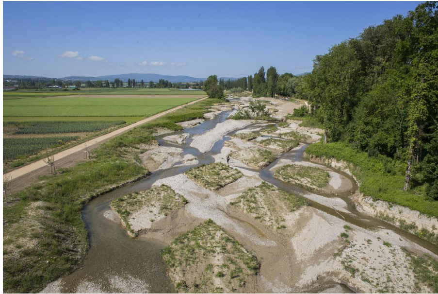
Figure 1.10. Exemple de restauration de cours d'eau en plaque de chocolat sur la rivière Aire (Suisse). Pour redonner un espace de liberté à la rivière, celle-ci a été déchenalisée, puis a pu retrouver sa dynamique naturelle à travers les bancs de sable en losange. Photographie : Biotec.
