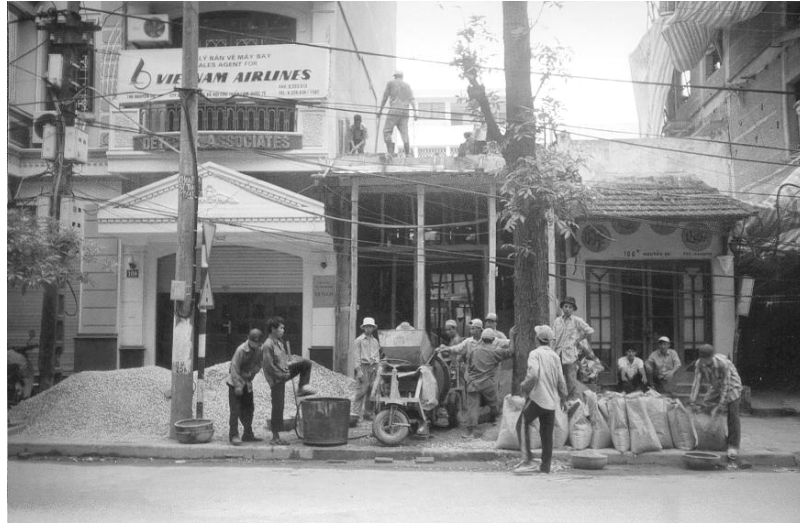
Figure 1.17 : Entreposage des matériaux dans la rue et fabrication du béton (photo par Jonathan Boucher et Dany Blackburn, 2002)
