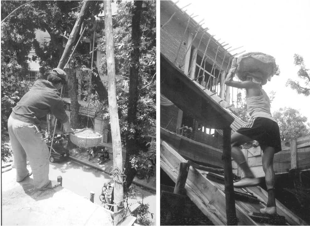
Figure 1.21 : Manutention du béton sur le chantier (photo par Jonathan Boucher et Dany Blackburn, 2002)
