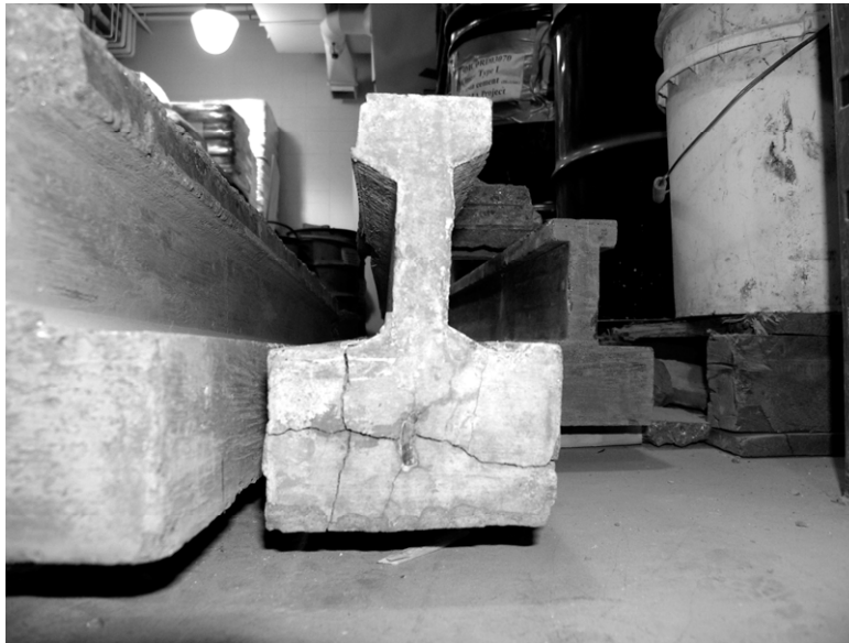
Figure 3.29 : Fissuration des poutres (Photo par Jonathan Boucher et Dany Blackburn, 2005)
