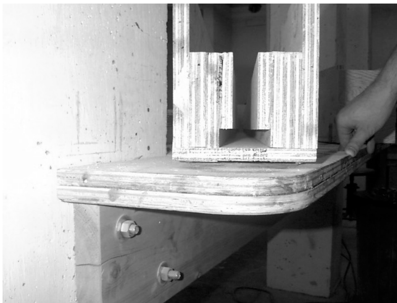
Figure 3.21 : Profil et disposition du coffrage (photo par Jonathan Boucher et Dany Blackburn 2004)
