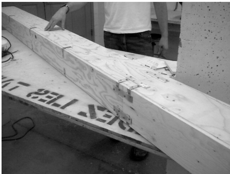
Figure 3.20 : Coffrage de bois (photo par Jonathan Boucher et Dany Blackburn, 2004)
