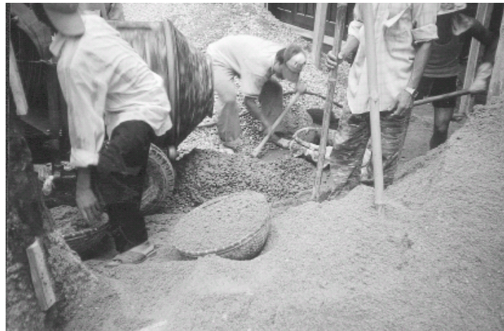
Figure 1.20 : Préparation du béton dans la rue (photo par Jonathan Boucher et Dany Blackburn, 2002)
