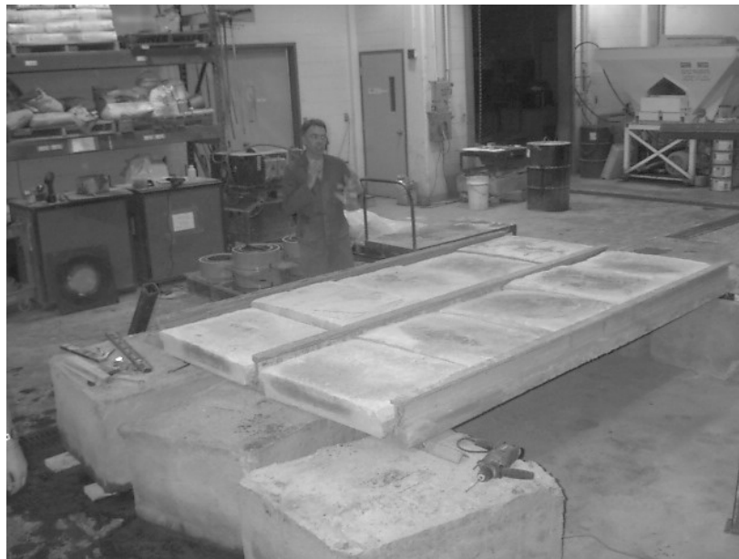
Figure 3.32 : Construction d'une section de plancher en grandeur réelle (photo par Jonathan Boucher et Dany Blackburn, 2005)
