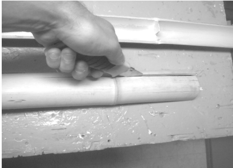
Figure 3.1 : Découpage des armatures (Photo par Jonathan Boucher 2003)
