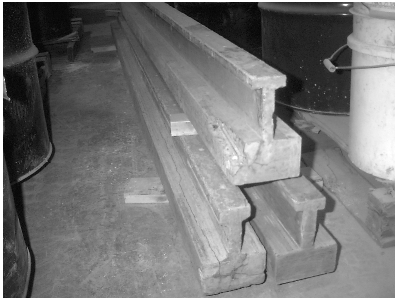
Figure 3.28 : Poutres décoffrées (photo par Jonathan Boucher et Dany Blackburn, 2004)
