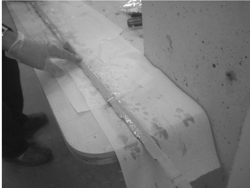
Figure 3.4 : Application du SIKAFLOOR 90 (photo par Jonathan Boucher, 2003)
