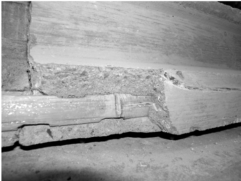
Figure 3.31 : Adhérence entre les armatures le béton suite au test de flexion (photo par Jonathan Boucher et Dany Blackburn, 2005)
