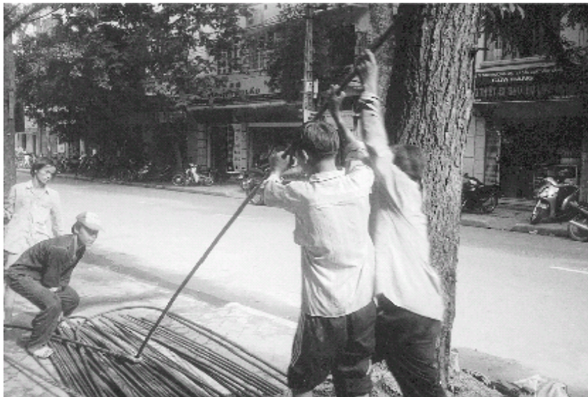
Figure 1.24 : Pliage des armatures d'acier par les ouvriers (photo par Jonathan Boucher et Dany Blackburn,. 2002)
