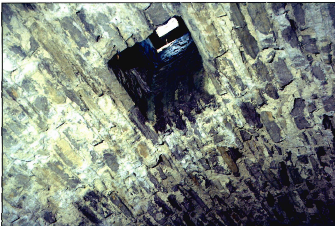
Figure 58 : Puits de ventilation 15A17 (BjFj-84-01-D8-18)
