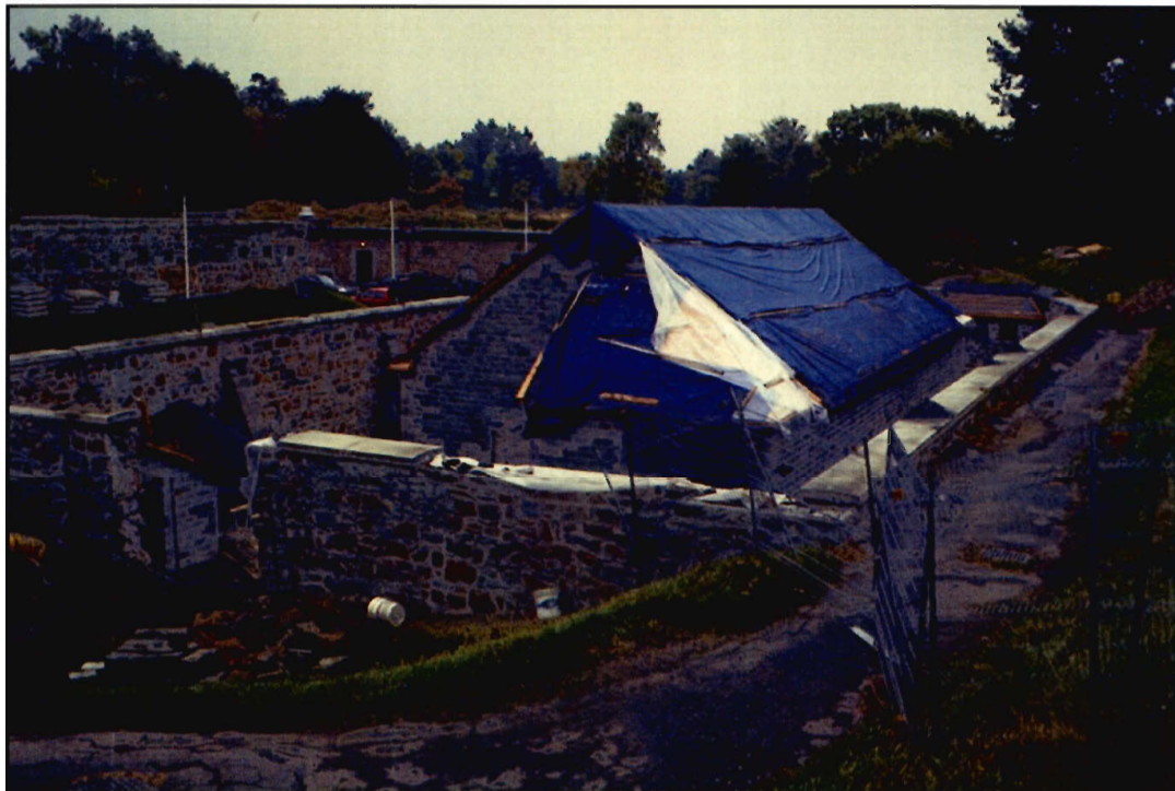
Figure 138 : Petite poudrière de l'île Sainte-Hélène en cours de restauration (BjFj-84-02-D5-16)
