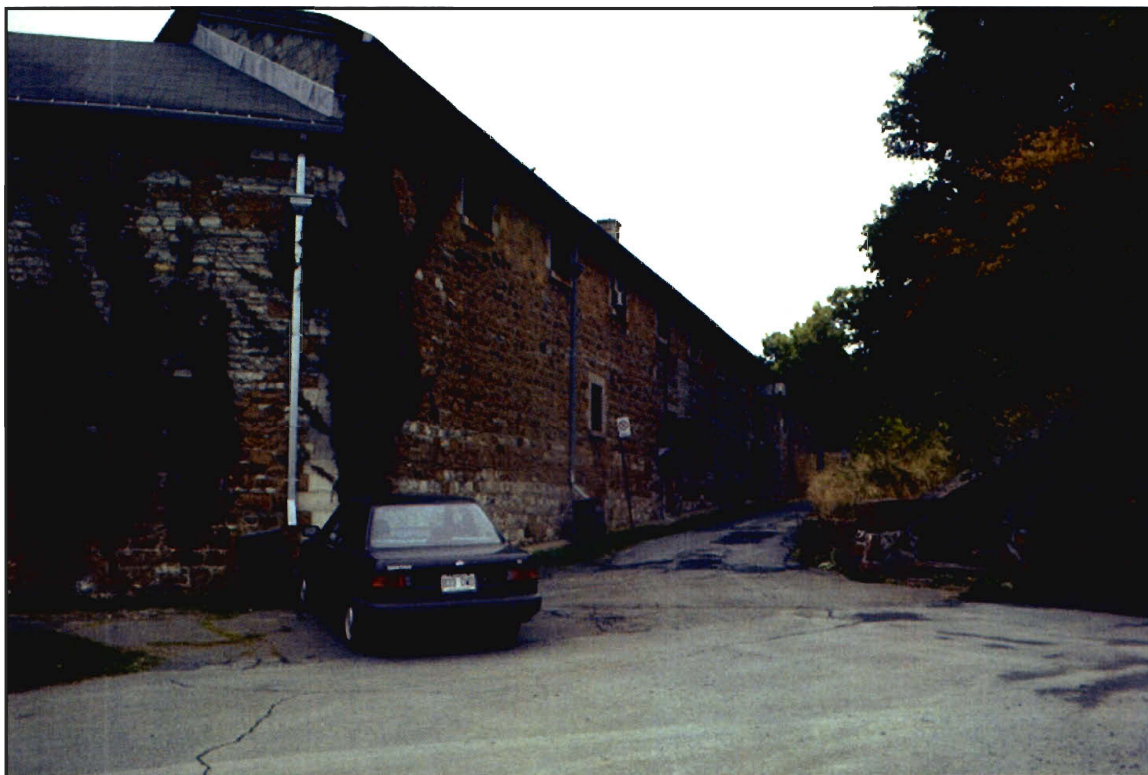
Figure 110 : Face droite de l'arsenal (BjFj-84-02-D5-23)
