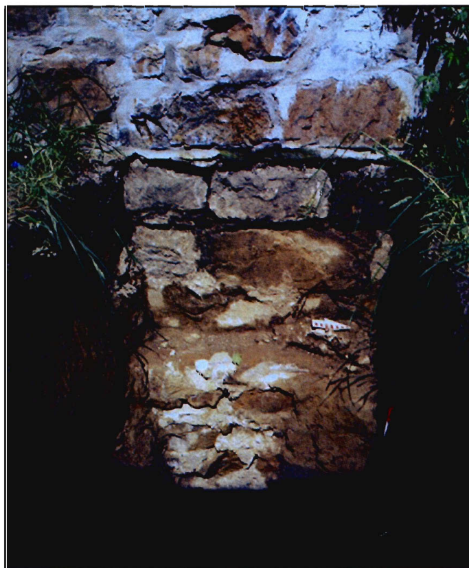
Figure 139 : Mur de fondation 10D1 du mur d'enceinte ouest (BjFj-84-01-D2-13)
