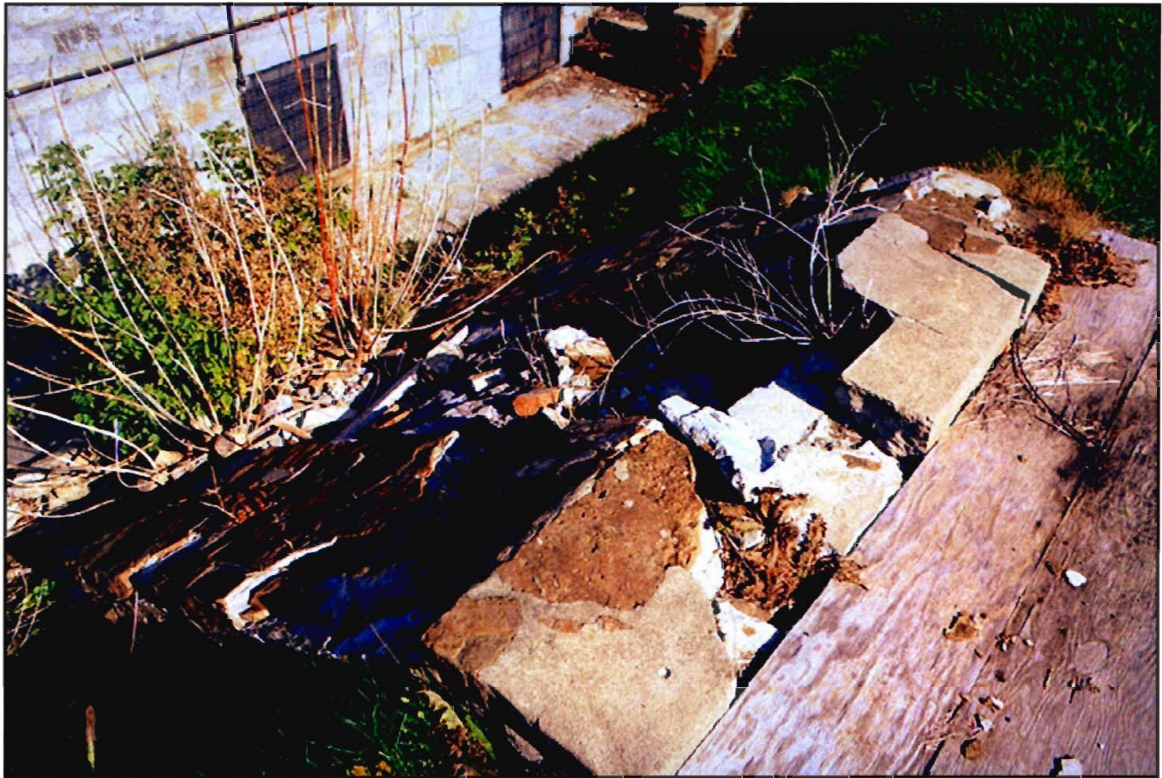
Figure 54 : Entrée du caveau avant l'enlèvement des débris (BjFj-84-01-D9-22)
