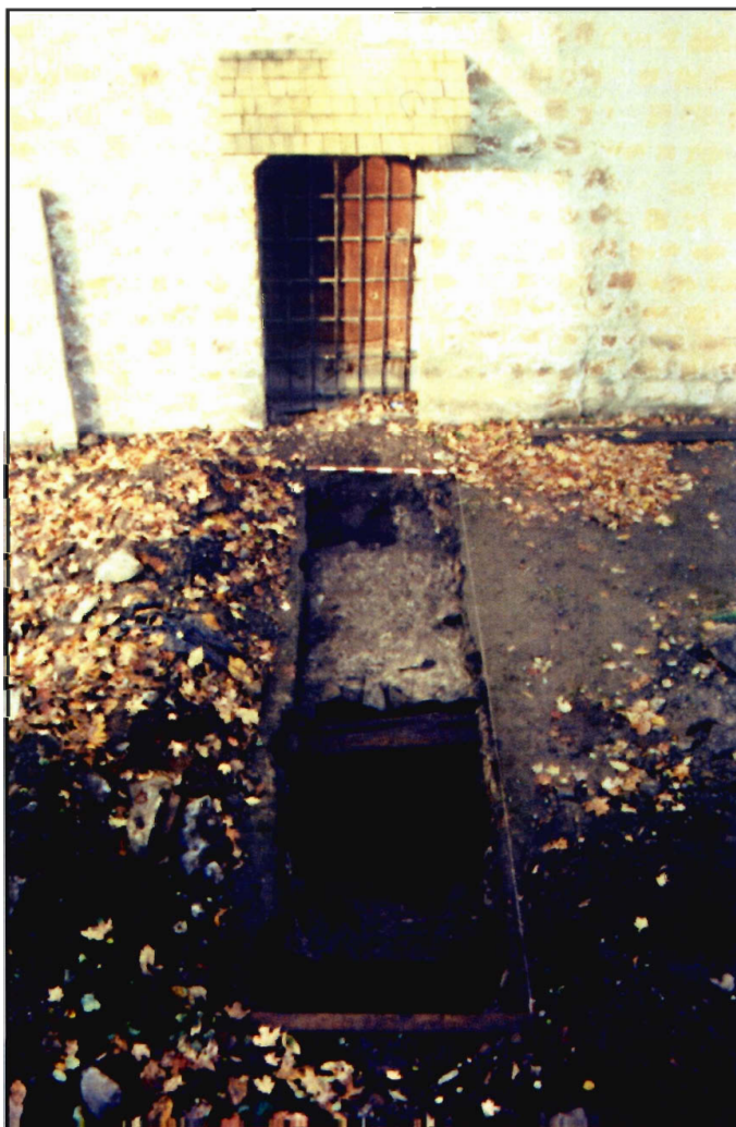
Figure 94 : Mur de fondation du porche est, rigole et drain découverts à l'arrière de la grande poudrière en 1999 (BjFj-84-99-D8-24)
