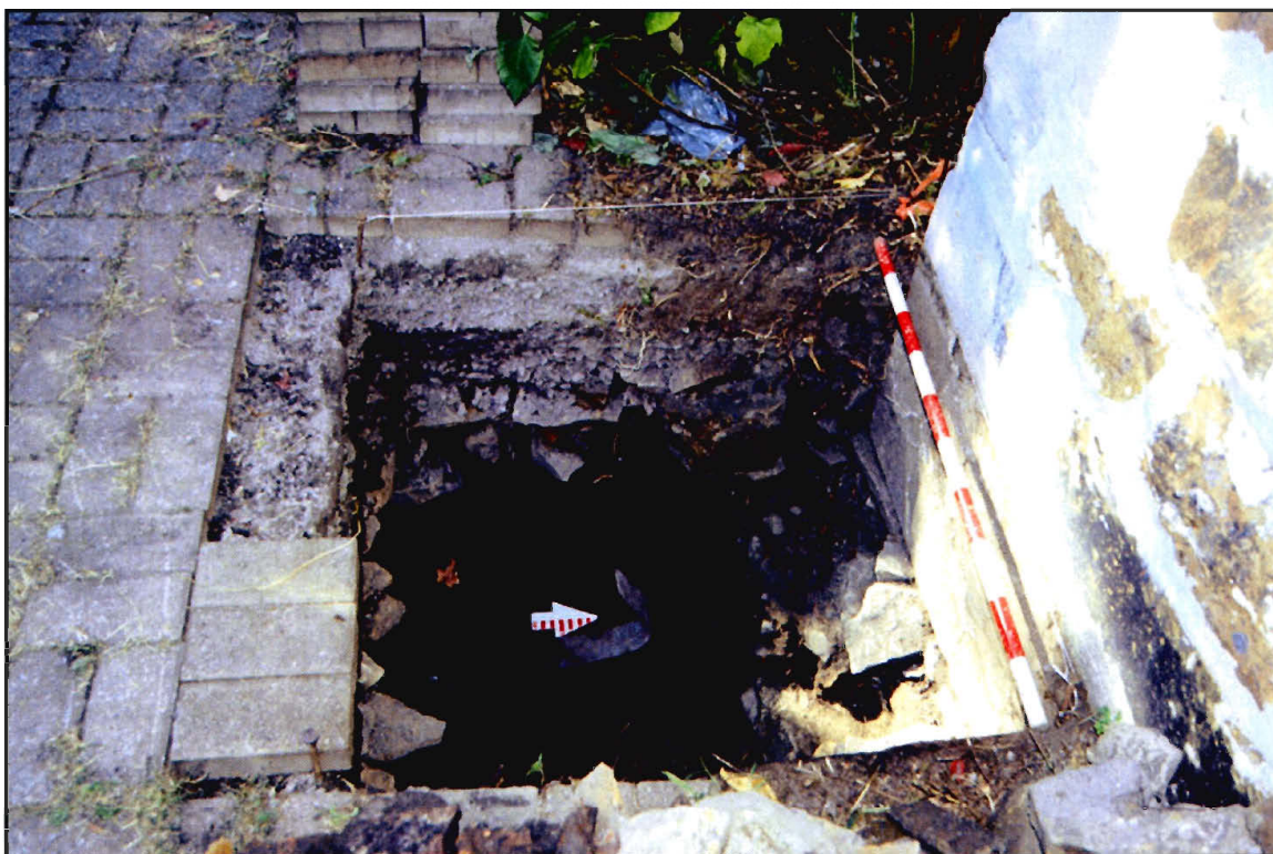
Figure 104 : Feuillard 30C9 et mur de fondation sud 30C12 de la grande poudrière (BjFj-84-04-D5-13)
