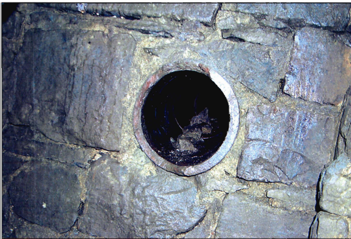
Figure 86 : Paroi est du regard 19G4
