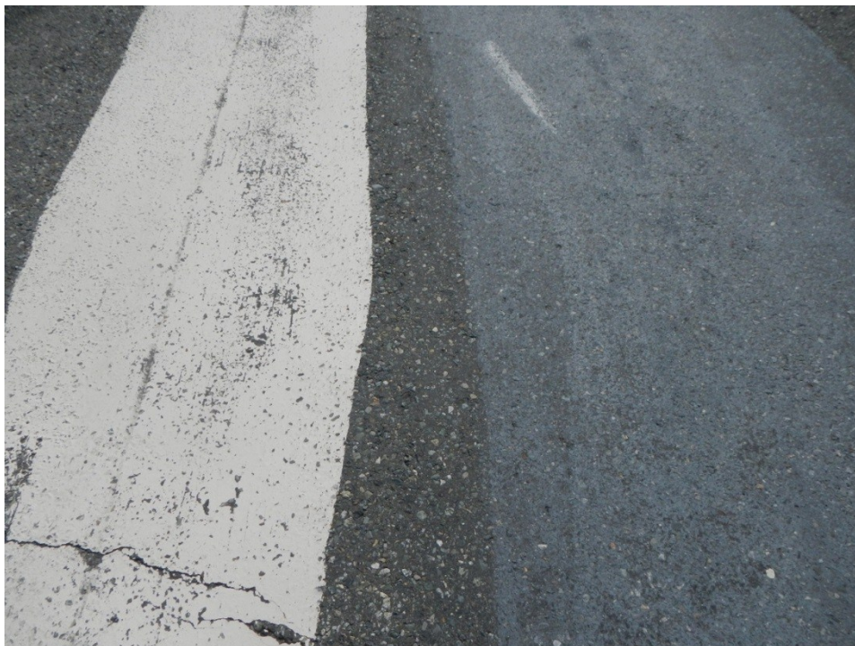
Figure 6.34: État des traces d'enduit effectuées sur un support de BST
