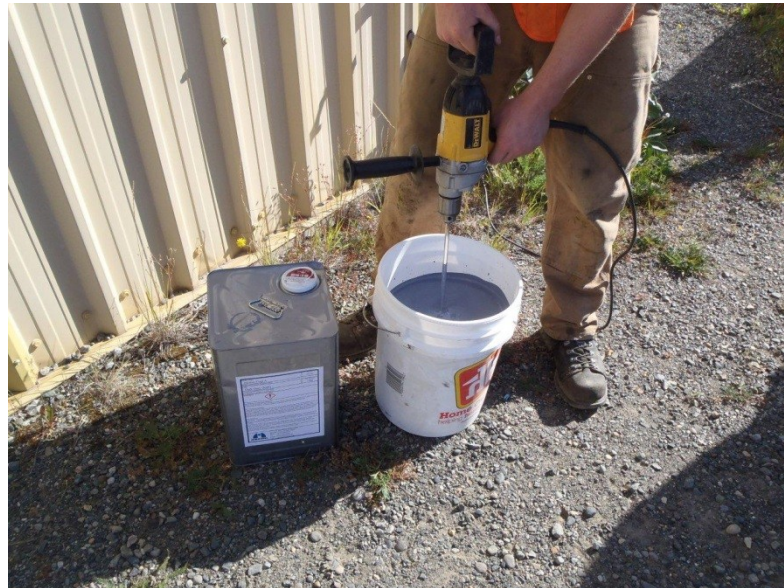
Figure 3.2 : Préparation de l'enduit Perfect Cool A (Photo: Yukon Highways and Public Works)
