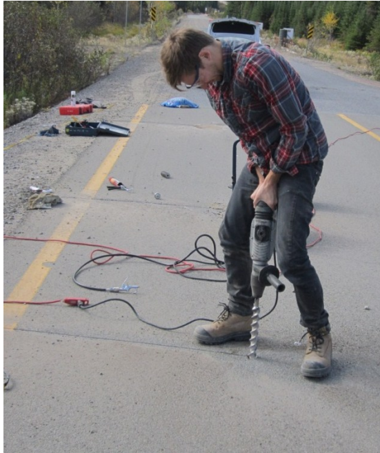
Figure A.8: Forage d'un trou pour accueillir une sonde
