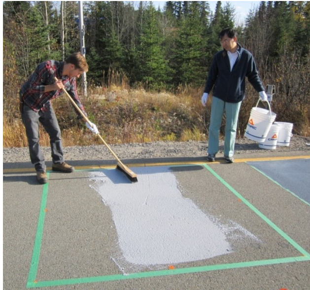
Figure A.23: Pose de la première couche de l'enduit Perfect Cool AP sur enrobé bitumineux à l'aide d'un balai (section E)
