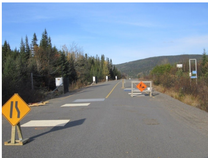
Figure A.29: Planche d'essai du SERUL complétée
