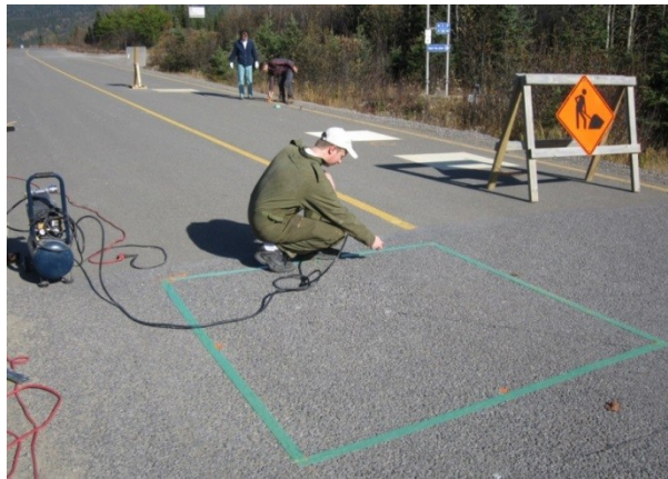
Figure A.18: Délimitation et nettoyage de la surface de traitement bitumineux de surface
