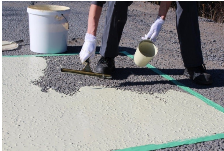
Figure A.14: Pose de l'enduit Colas-A sur la section de traitement de surface (section BST-3)
