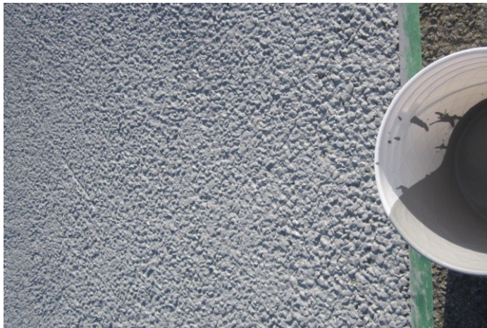
Figure A.28: Texture de la section de Perfect Cool A posé sur traitement bitumineux de surface (section BST-1)
