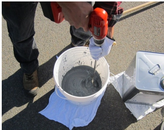
Figure A.21: Mélange de la peinture et du sable à l'aide d'un mélangeur à peinture
