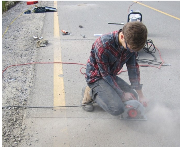
Figure A.9: Sciage d'une entaille à la surface du revêtement
