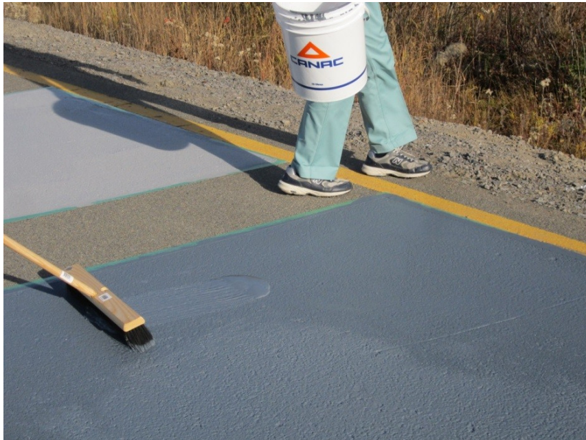
Figure A.26: Pose de la deuxième couche de l'enduit Perfect Cool A sur enrobé bitumineux à l'aide d'un balai (Section D)
