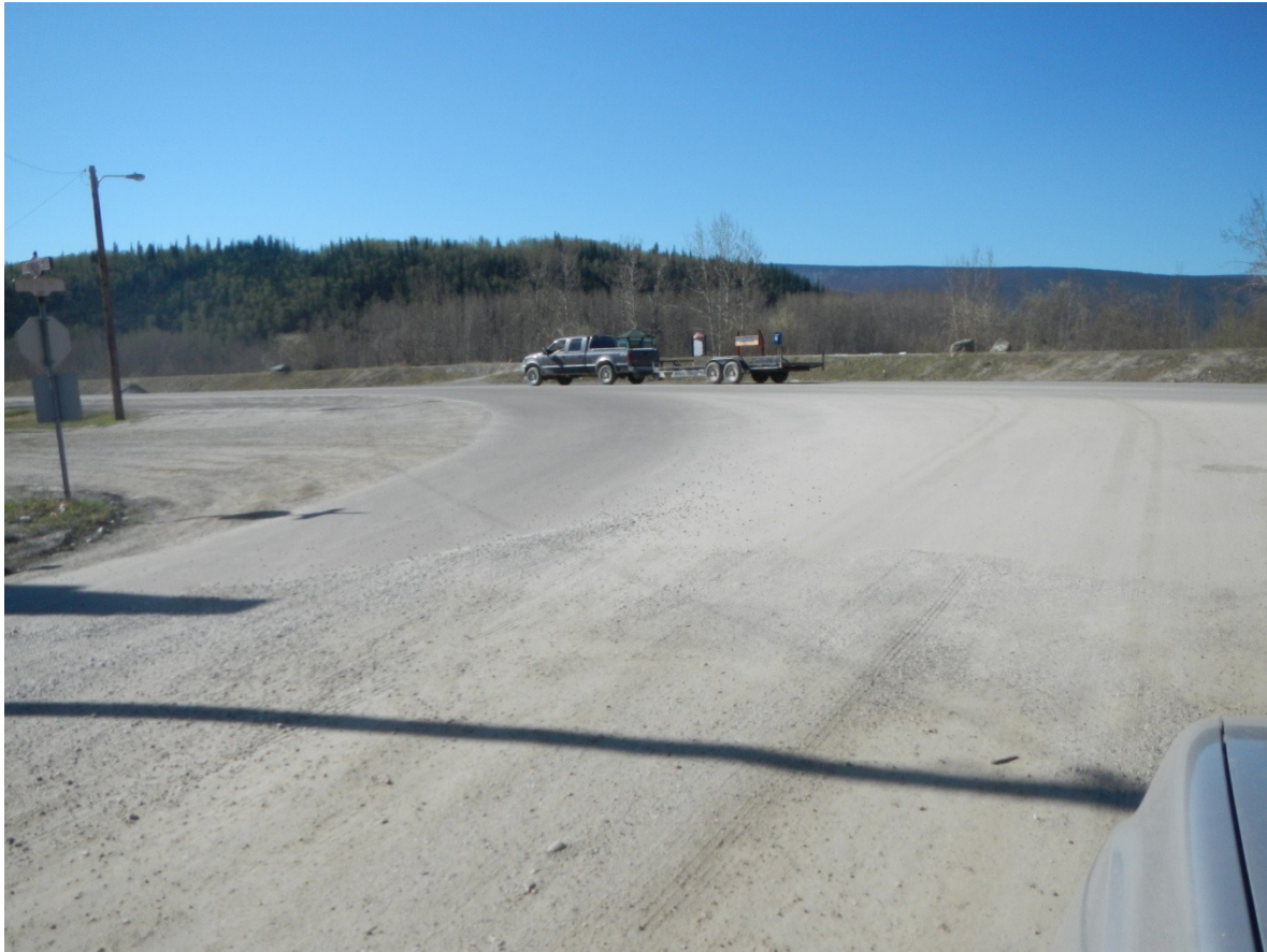
Figure A.38: Intersection de la Front Street et de la Fifth Avenue à Dawson City
