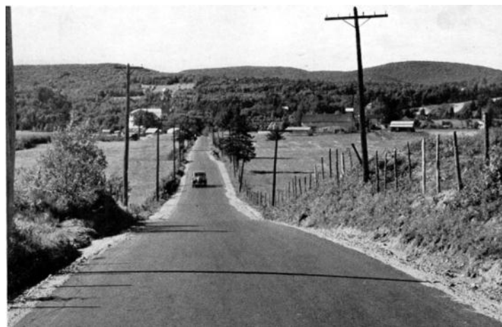
Fig. 44 Route de Deschambault entre Saint-Augustin-de-Desmaures et le Lac-Saint-Joseph, 1938. Source : Ministère de la Voirie du Québec (1938), p. 94.
