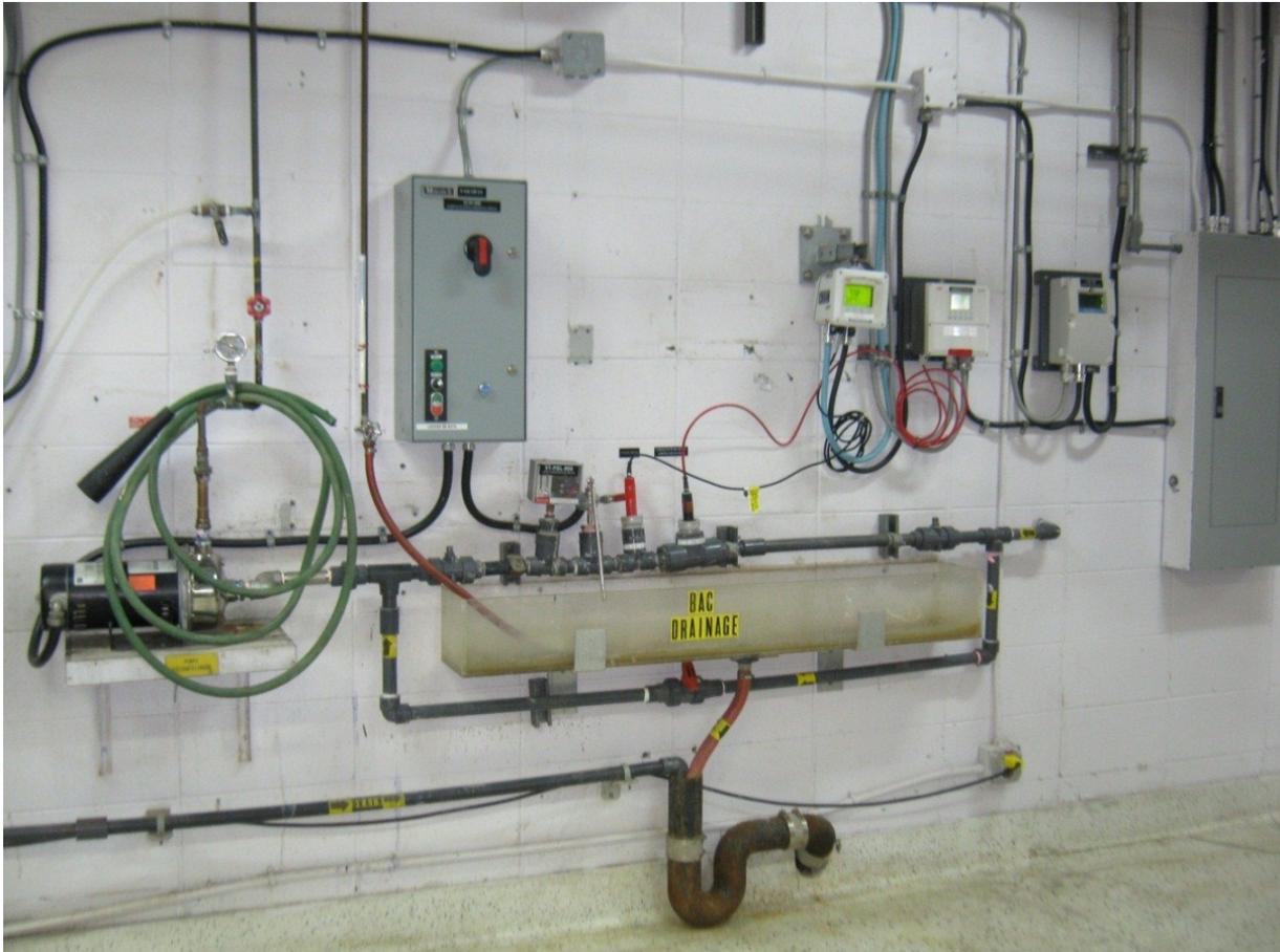
Figure 48 - Ligne de soutirage d'eau brute sur laquelle sont installés les analyseurs de pH, de conductivité et de température
