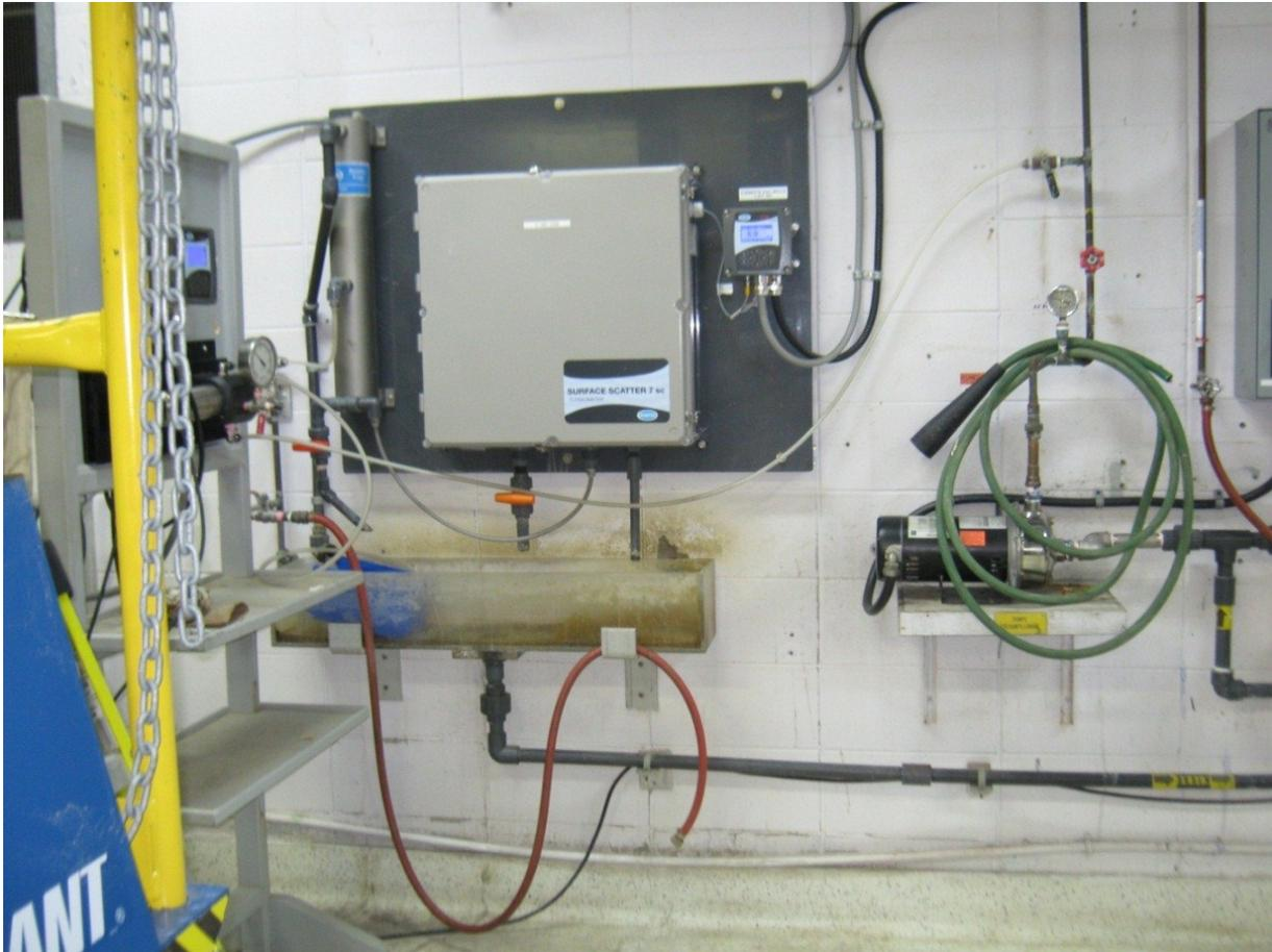
Figure 49 - Analyseur de turbidité (Surface Scatter 7 sc)
