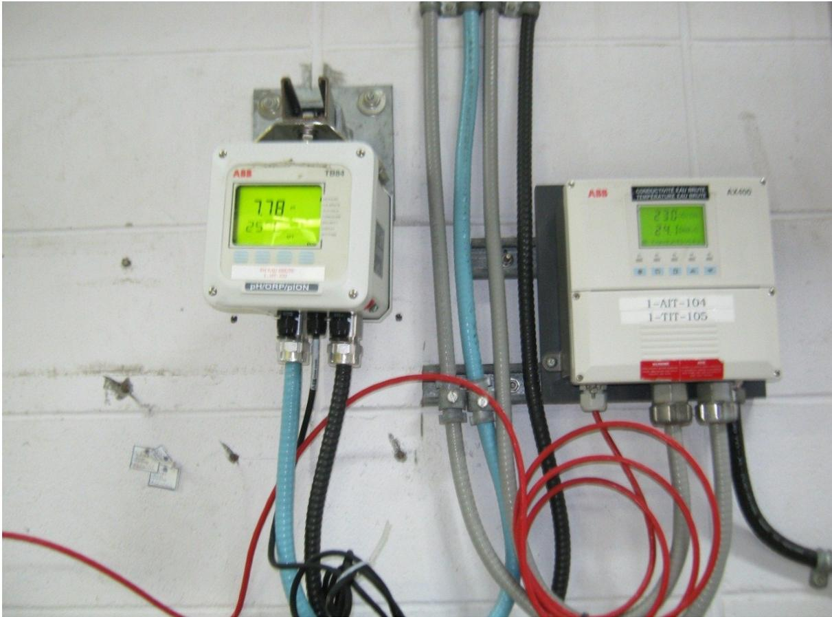
Figure 47 - Transmetteurs de pH (TB84), de conductivité et de température (AX416)
