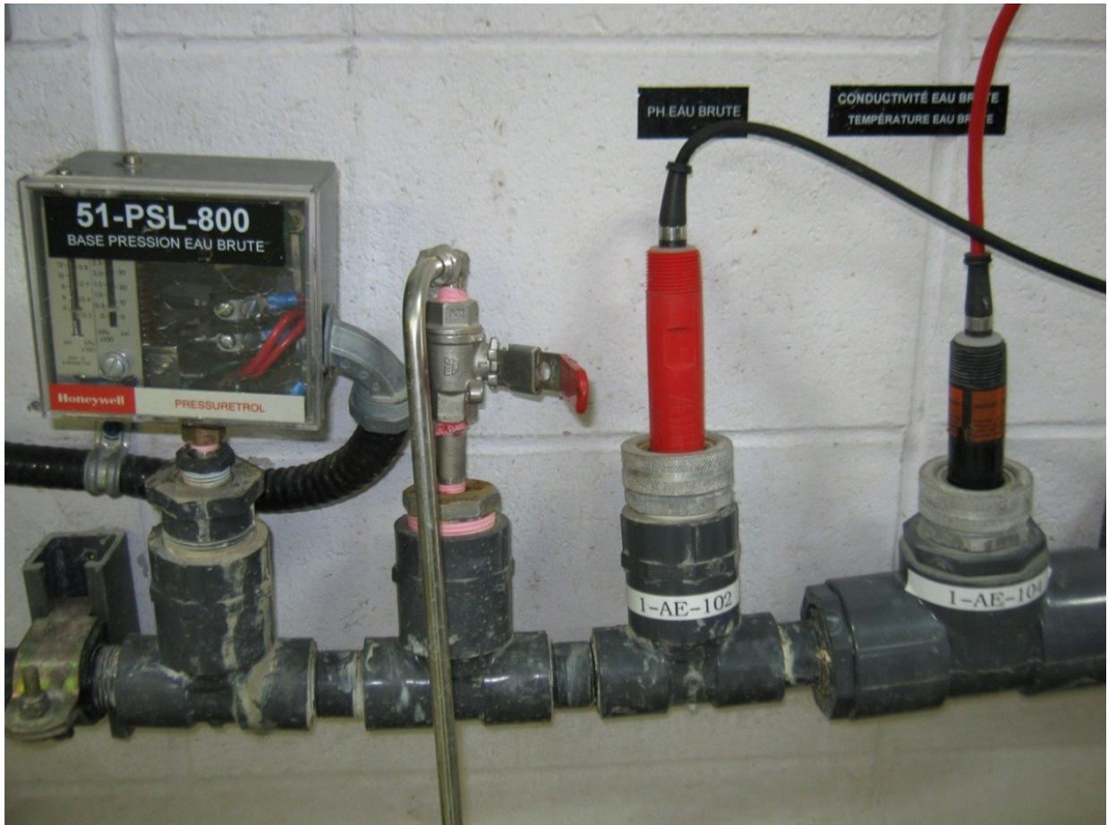
Figure 45 – Analyseurs de pH (TBX556), de conductivité et de température (TB4)
