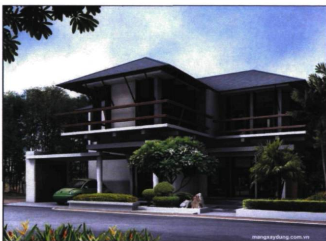
Figure 4.2.3.2.1: Tôle sur la toiture dans un projet d'architecture au Vietnam – la villa (Photo tirée d'Internet).
