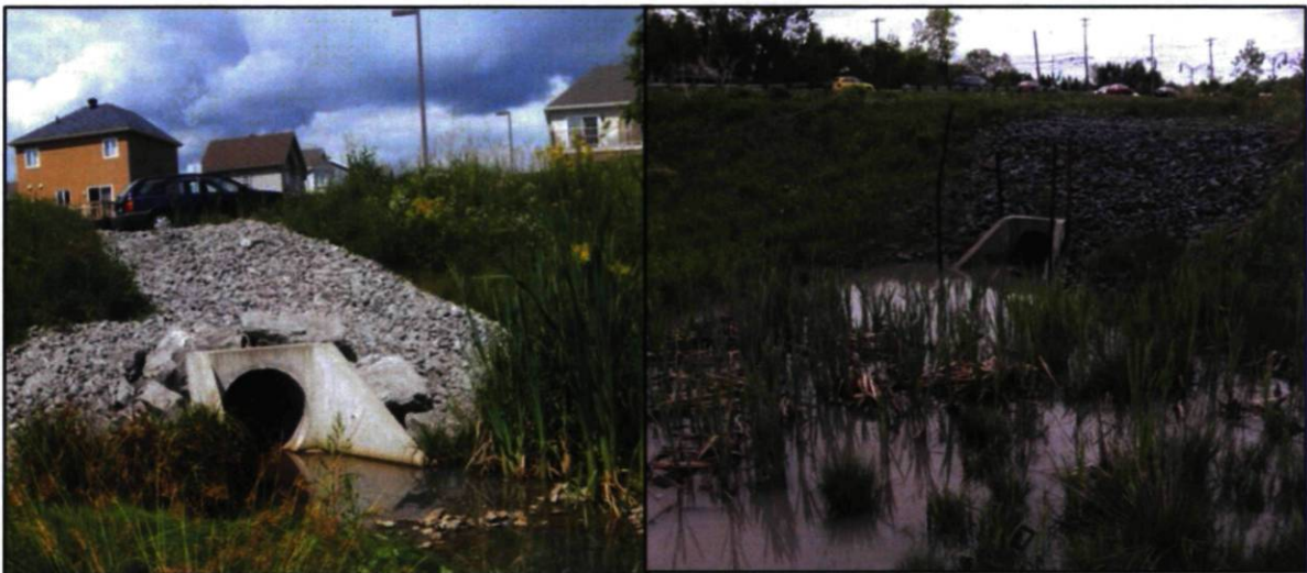
Figure 11 – Ouvrages d'entrée et de sortie du bassin d'orage Chauveau
