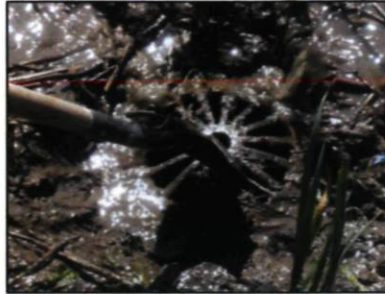
Figure 12- Drain de fond du bassin d'orage Chauveau une fois déterré
