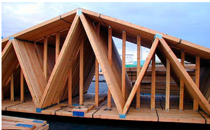
Figure 8 : Fermes de toit à connecteurs métalliques (WTCA 2005)
