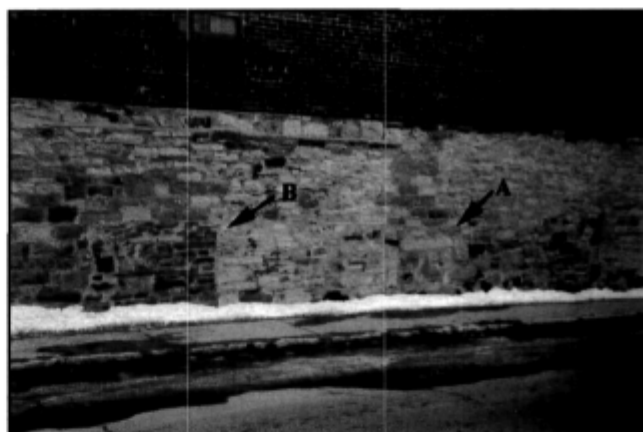
fig. 18 Porte de communication (A) et emplacement d'une cloison (B) dans le mur arrière. Photo Robert Nadeau 2003.
