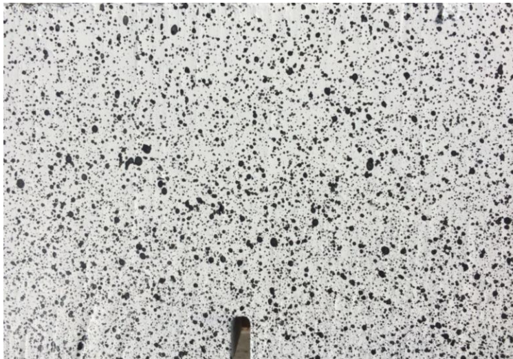
Figure B-6. Texture de la surface d'une poutre
