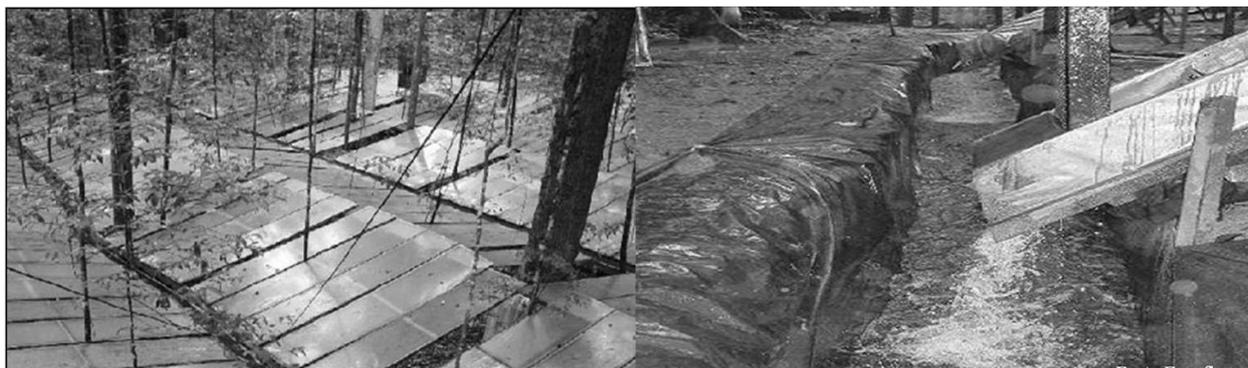
Fig. 2 – Painéis coletores de água, calhas de drenagem e trincheira.
