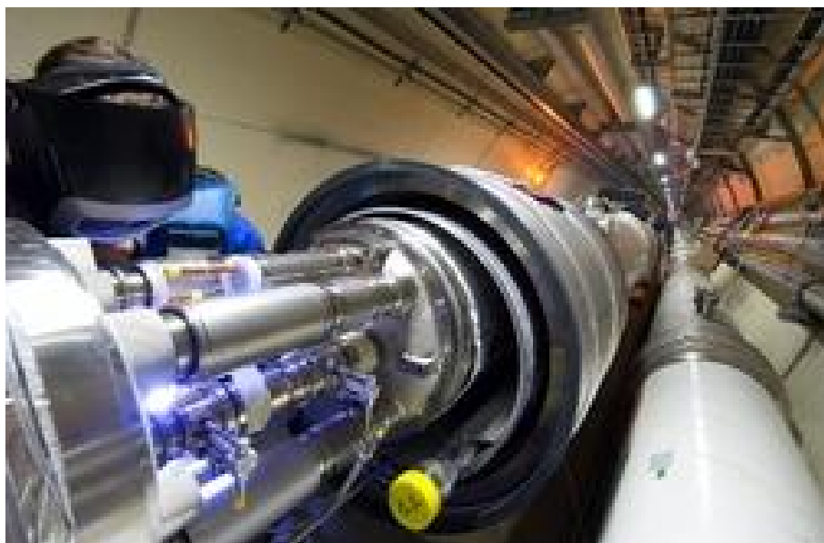
Figura 2.2 - Foto del tunnel sotterraneo che ospita la beam-pipe di LHC durante i lavori di installazione.
