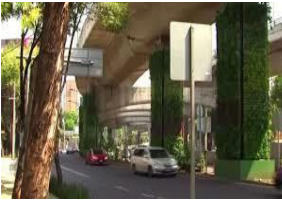
Şekil 7. Taşıt Trafik Hattında bulunan köprü alt geçidi.
