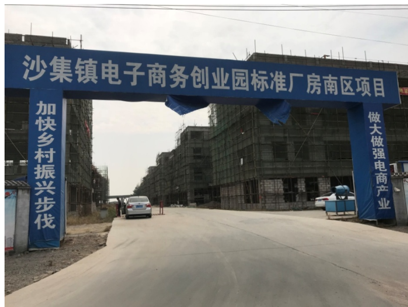
図5-13 沙集電子商務創業パーク第2期（建設中）
