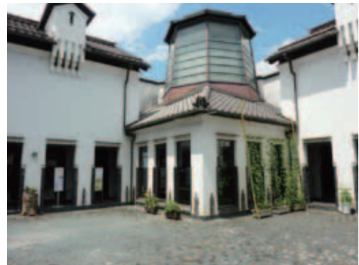
中庭から見たエントランスホール
