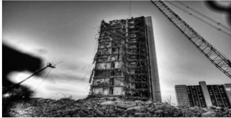
Figura 2. Demolición del conjunto Cabrini, Chicago
