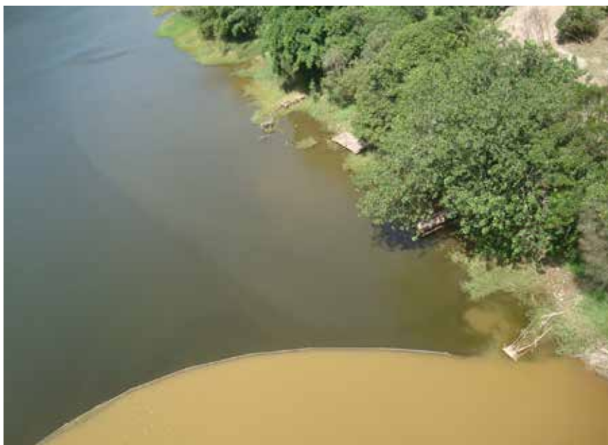
Figura 1: Aplicação de barreiras flutuantes na obra do trecho Sul do Rodoanel, notar diferença na tonalidade da água Fonte: IPT, 2008
