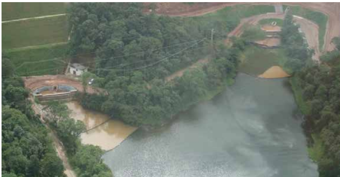
Figura 2: Aplicação de sequências de barreiras flutuantes na obra do trecho Sul do Rodoanel, notar diferença na tonalidade da água
