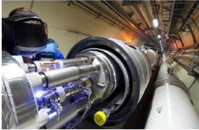
Figura 2.2: Foto del tunnel sotterraneo che ospita la beam-pipe di LHC durante i lavori di installazione.
