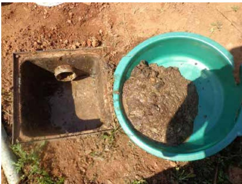
**Figura 4** - Caixa de gordura instalada após a pia da cozinha. Na bacia ao lado encontram-se os sólidos retirados durante a limpeza semestral.
