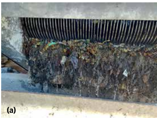
Figura 5 – a) Detritos retidos em uma unidade de peneiramento de 6 mm; b) Presença de detritos em lodo e espuma desaguados em leitos de secagem.
