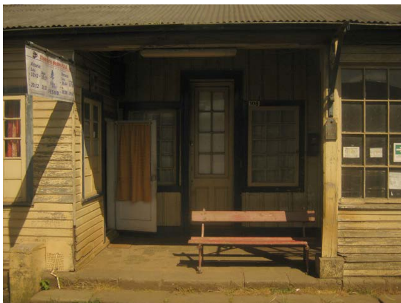
Fig. 2. Estación P.U.A. Entrada a la estación.
