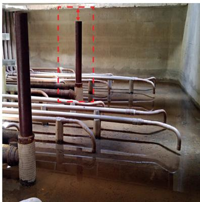
**Figura 4** – Tubería de descarte de lodo posicionada muy cerca del deflector de gases, en discordancia con el diseño.
