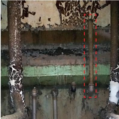
**Figura 3** – Instalación del punto de muestreo encima del límite del compartimento de decantación, en discordancia con el diseño.
