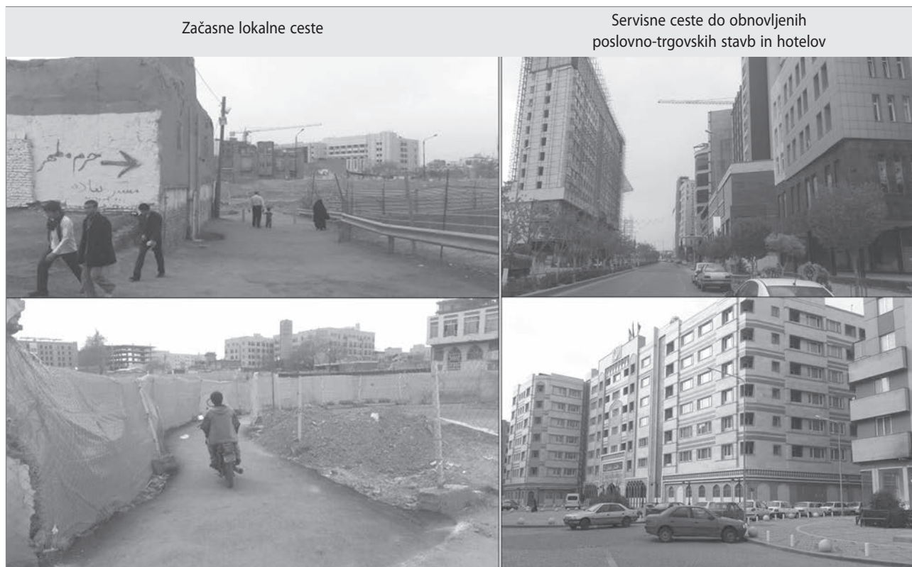
Slika 3: Primerjava začasnih lokalnih cest in servisnih cest do novih poslovno-trgovskih stavb in hotelov (foto: Navid Forouhar)
