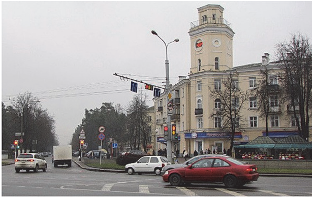
Фото 1. Сохранившееся довоенное здание бывшего военного городка на углу Партизанского проспекта и улицы Центральной г. Минска
