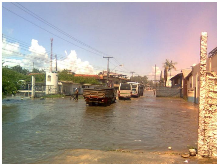
Figura 7: Maré de sizígia do dia 21/03/2011 em área adjacente ao canal João de Deus, na Avenida/Canal Bernardo Sayão (BHEN), com elevação da maré 3,8 m e temperatura de 31°C. Fonte: o autor e Diretoria de Hidrografia e Navegação (DHN); Centro de Hidrografia da Marinha (CHM); Banco Nacional de Dados Oceanográficos (BNDO).
