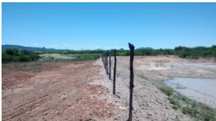
Figura 6. Barragem de terra.
