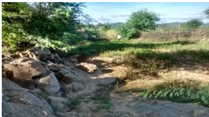
Figura 12. Ponto C12 – canal de leito rochoso próximo a confluência do rio principal e rio da Varzinha.
